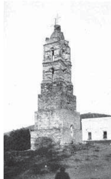
Fotografía del centro INAH Sinaloa Torre del colegio de Sinaloa. Foto: INAH, archivo de la casa de la cultura Sinaloa de Leyva, antes de perder sus cuerpos superiores.
