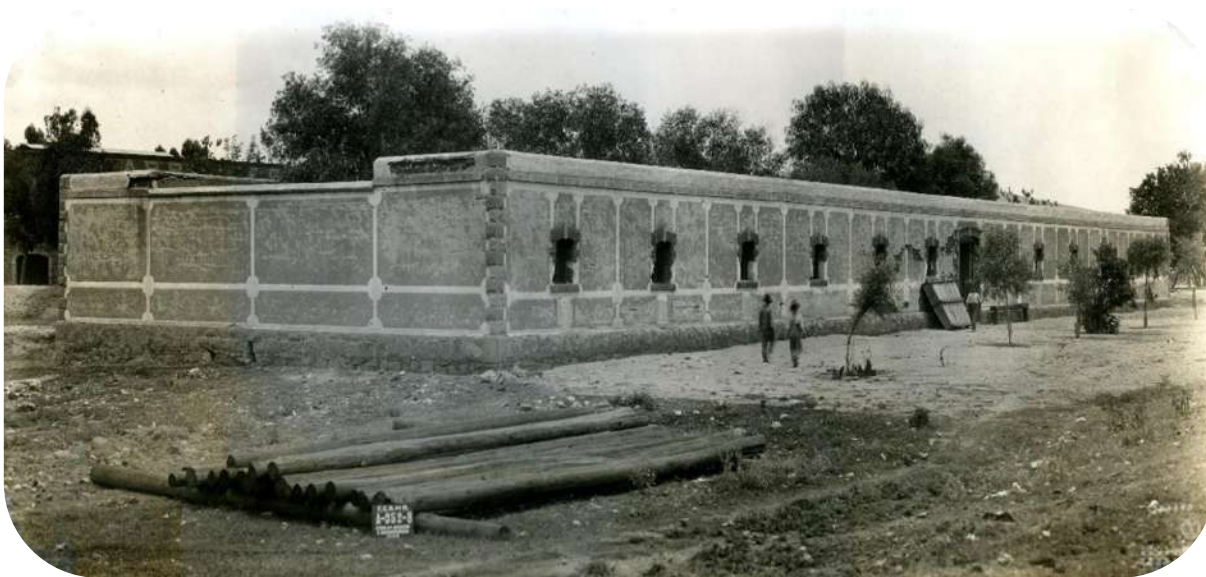
Foto129: Caseta de mampostería, adobe y azotea con esquinas de piedra y mochetes para la sección de Irapuato, vista exterior. Fondo FNM, Sección: Comisión de Avalúo e Inventarios, Secretaría de Cultura-CNPPCF-CEDIF, 1926
