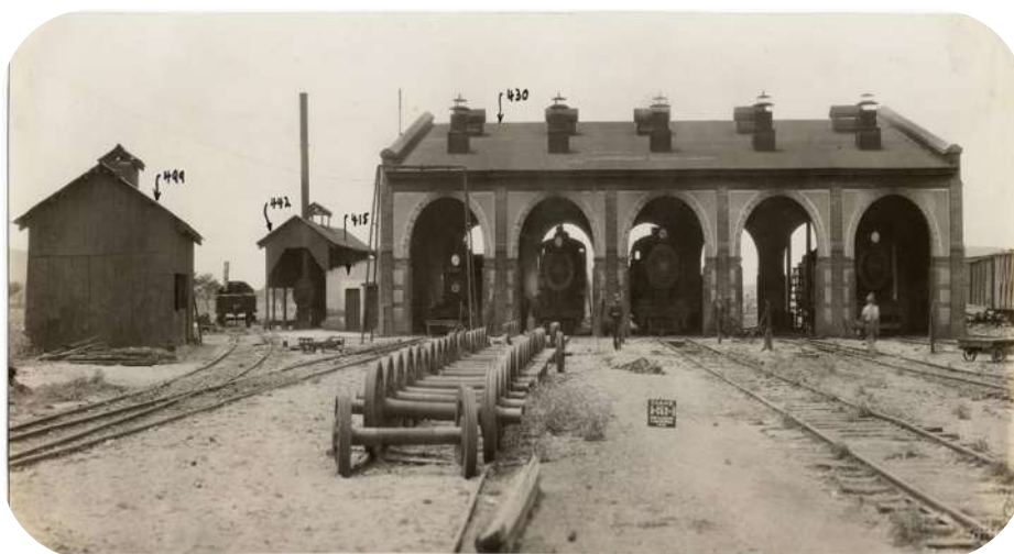
Foto 124: De izquierda a derecha: caseta de lámina para arenero, caseta de madera y lámina para caldera al sur de la casa de máquinas, caseta de adobe y lámina para bodega de herramientas, y casa de máquinas para 5 locomotoras. Fondo FNM, Sección: Comisión de Avalúo e Inventarios, Secretaría de Cultura-CNPPCF-CEDIF, 1926
