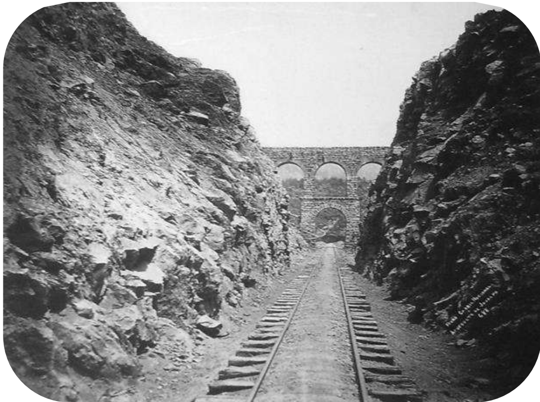
Foto 139: Tajos que se hacen en los cerros para que el tren pase (Yanes-1986)
