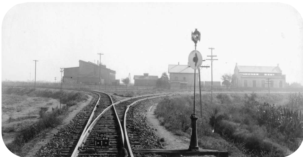
Foto 122: Entronque de Irapuato. Detalle de vía en el empalme de la rama norte de la "Y" en curva a la izquierda con el troncal a Guadalajara, que sirve también de rama sur. Fondo FNM, Sección: Comisión de Avalúo e Inventarios. Secretaría de Cultura-CNPPCF-CEDIF, 1929.
