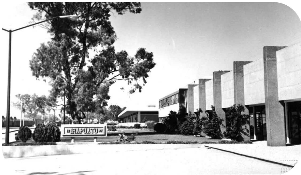
Foto 114: Fachada de la estación, cuya construcción inició en 1964 y fue inaugurada en 1969. Oficinas y bodega de carga. Fondo FNM, Sección: Revista Ferronales, Secretaría de Cultura-CNPPCF-CEDIF, 1990
