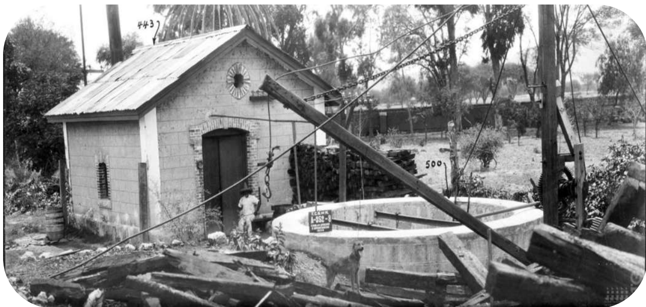
Foto 134: Caseta de mampostería y lámina para la caldera, y noria revestida de mampostería con bomba para agua. Fondo FNM, Sección: Comisión de Avalúo e Inventarios, Secretaría de Cultura-CNPPCF-CEDIF, 1926
