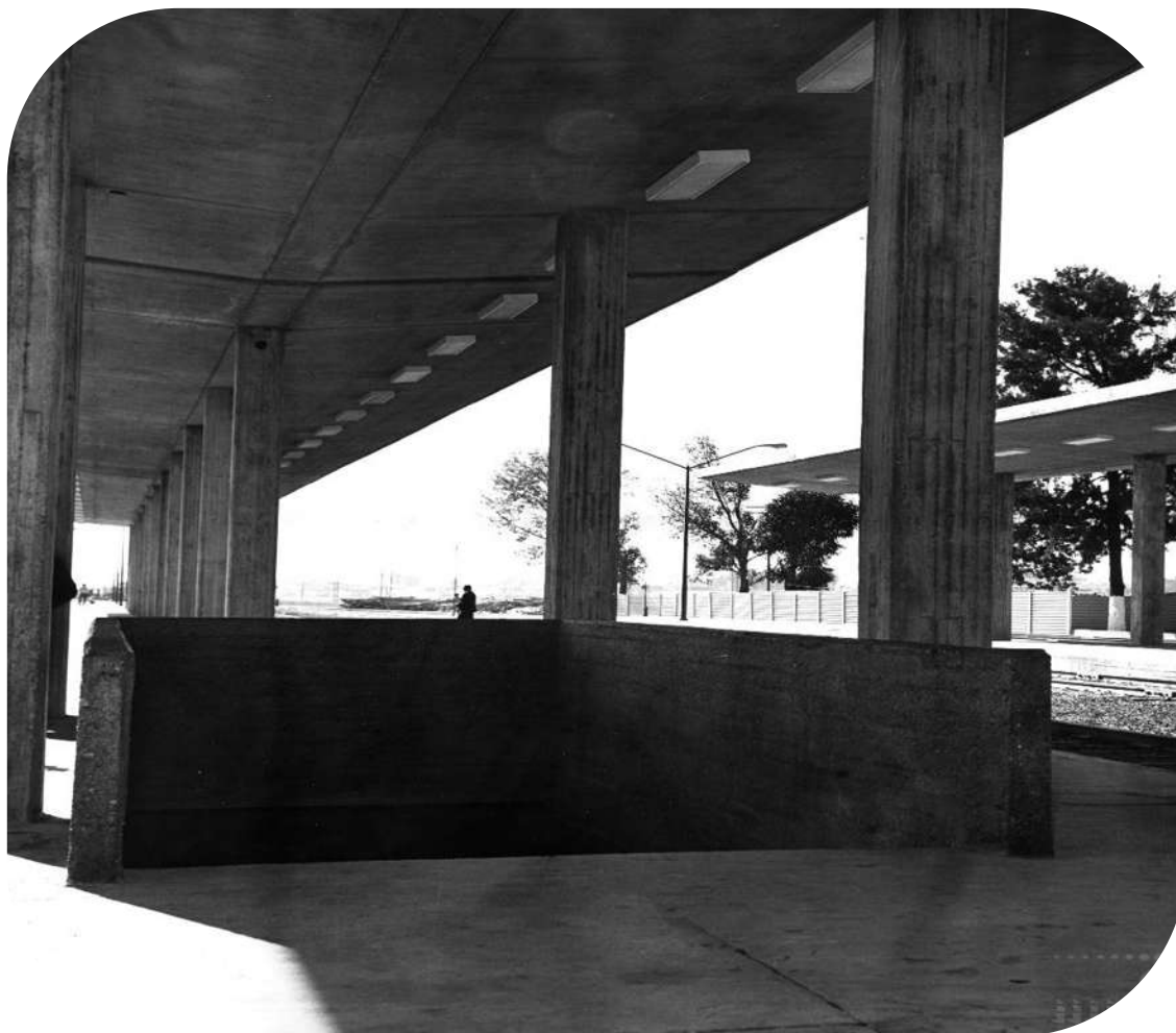
Foto 47: Andenes y el túnel ubicados en el patio de la nueva estación ferroviaria puesta en servicio en enero de 1969.
