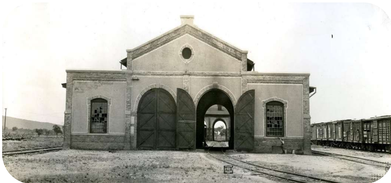
Foto 125: Taller mecánico de Irapuato, edificio de mampostería, tabique y lámina. Fondo FNM, Sección: Comisión de Avalúo e Inventarios. Secretaría de Cultura-CNPPCF-CEDIF, 1926
