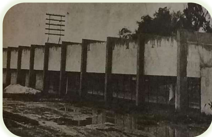
Foto 44: Avances en la construcción de la estación de Irapuato. Así figuraba en septiembre 1966
