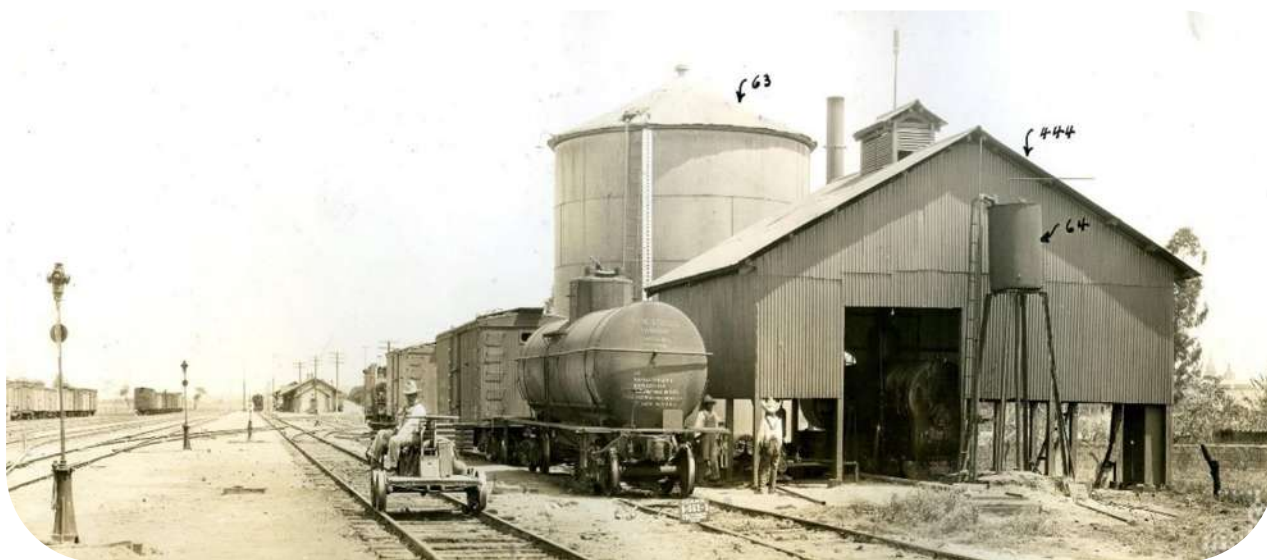
Foto 132: Cobertizo de madera y lámina para casa de calderas y bomba. Tanque de fierro para almacenamiento de aceite, y tanque de fierro en soporte de rieles para almacenamiento de la caldera. Fondo FNM, Sección: Comisión de Avalúo e Inventarios, Secretaría de Cultura-CNPPCF-CEDIF, 1926
