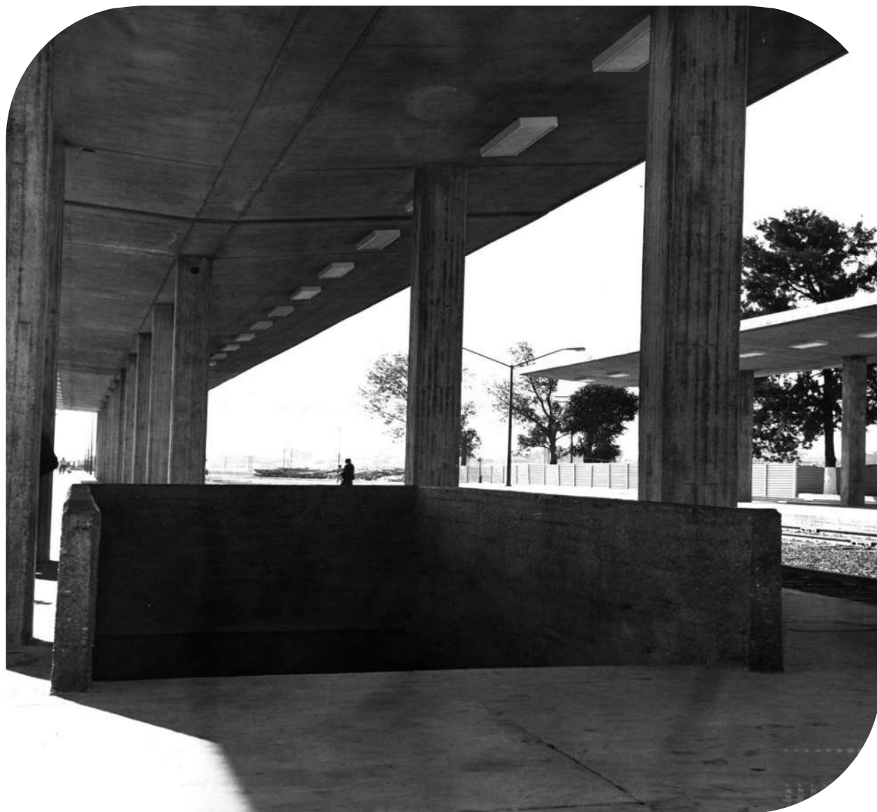
Foto 116: Salida y/o entrada del paso a desnivel inferior para pasajeros con acceso a los andenes, estación de Irapuato. Fondo FNM, Sección: Revista Ferronales, Secretaría de Cultura-CNPPCF-CEDIF, 1990
