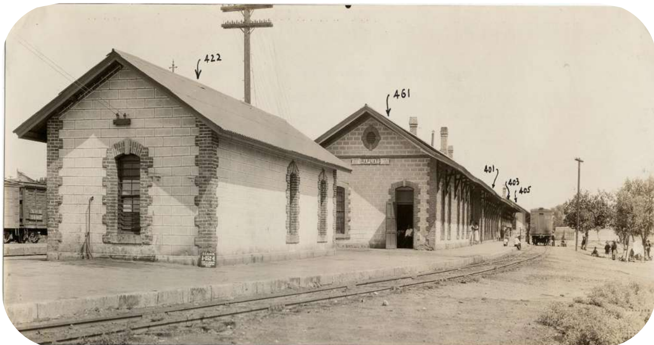
Foto 113: Edificio de mampostería, tabique y lámina para oficina del jefe de patio, para restaurante, oficina de la estación de Irapuato, oficina y bodega del tren Express, y muelle para bodega de carga, posterior y lado norte. Fondo FNM, Sección: Comisión de Avalúos e Inventarios. Secretaría de Cultura-CNPPCF-CEDIF, 1926
