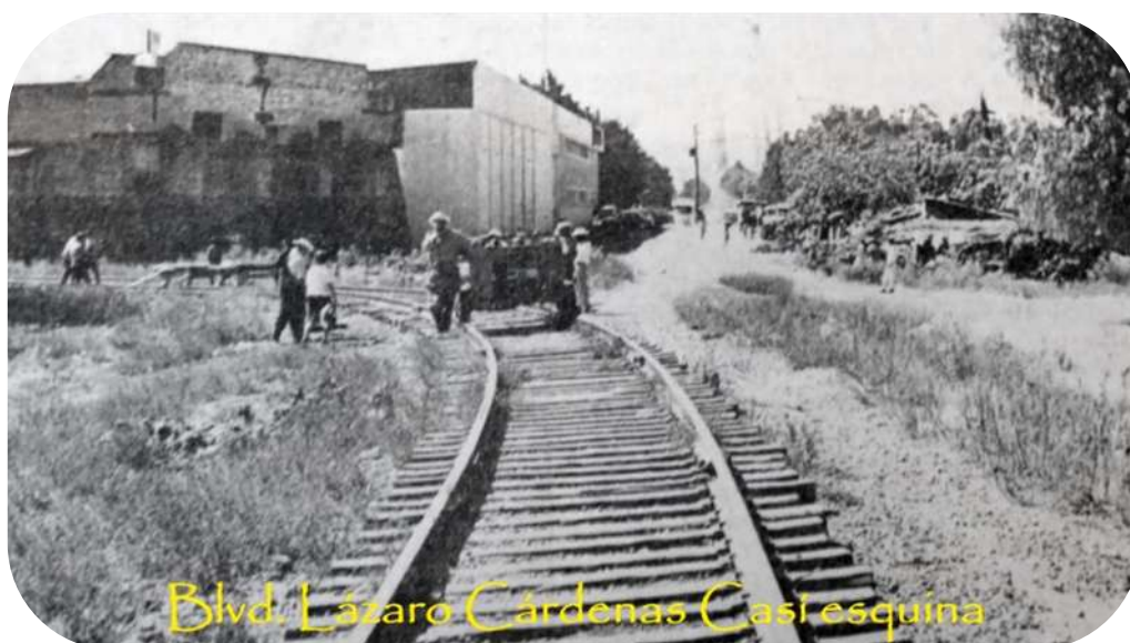
Foto 51: Trazo de las vías con destino a Guadalajara ubicadas en el bulevar Lázaro Cárdenas
