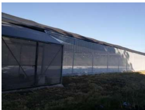
Figura 3.3 Infraestructura acondicionada con malla sombra 30% y malla antiáfido en la parte lateral.
