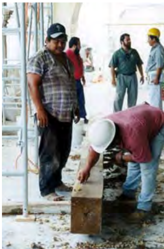
Figura 8. Restauración en obra.
