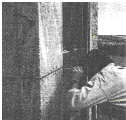
Figura 4. Prueba con el borescopio.
