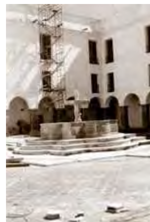
Figura 11. Vista de la restauración.
