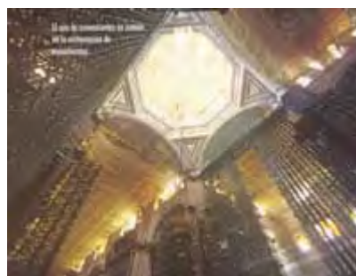
Figura 9. Vista de la restauración.
