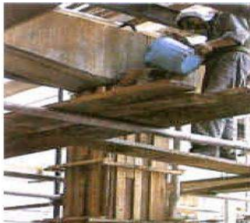
Figura 2.2 Operación de vertido del concreto para el refuerzo de pilas (Espeche A., 2007).
