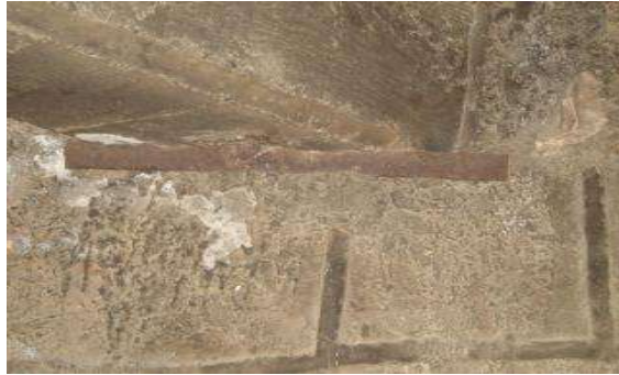
Figura 3.5 Apoyo metálico en nervaduras.
