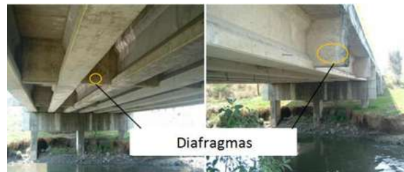
Figura 4.5 Puente ubicado en el kilómetro 24 de la carretera Atlacomulco-Toluca
