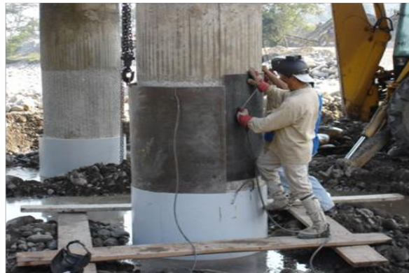
Figura 2.4 Rehabilitación de pila de puente con encamisado de placas de metal (fuente: www.inco.gov.1010/./FILE_COCOIMG1119JPG ).
