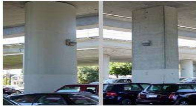
Figura 2.5 Rehabilitación de las pilas de un viaducto que fueron reforzadas con la técnica de encamisado metálico elíptico relleno con mortero. La imagen de la derecha muestra la sección antes de ser intervenida (Espeche A. 2007).
