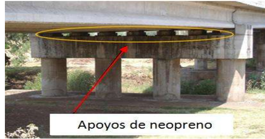
Figura 4.6 Puente ubicado en la carretera Maravatío-Atzacmulco (López, 2011).
