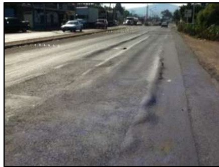
Figura 9 Formación de roderas en la superficie de rodamiento.
