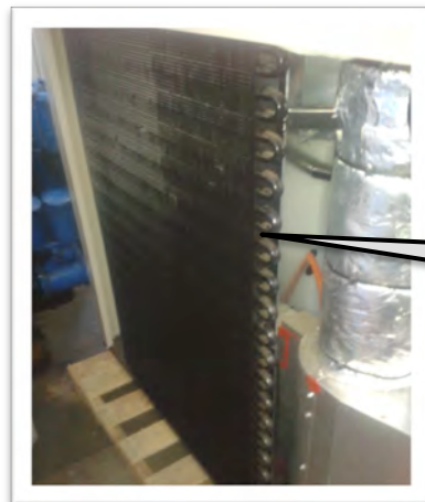
Figura 2-11. Intercambiador de tubos de la máquina ROBUR.
