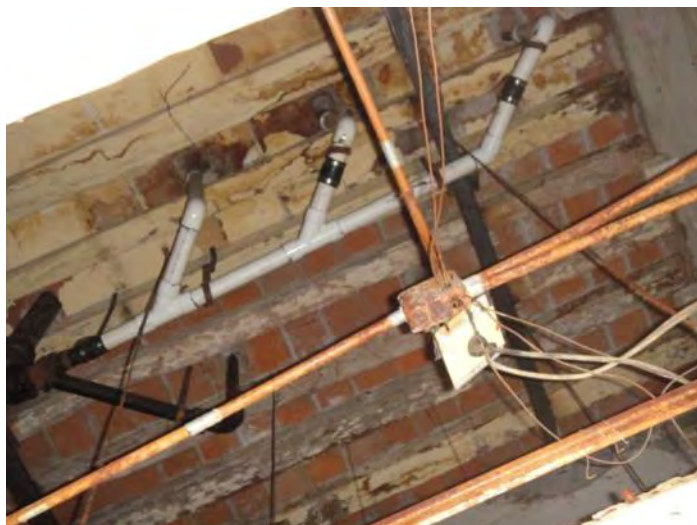
Figura 35. Fotografía de viguería con tapa de ladrillo en losa de entrepiso Fuente: Catalina Borbolla Gaxiola
