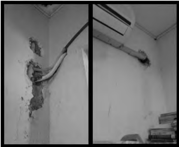
Figura 08. Perforación de muros interiores en el Archivo Histórico General del estado de Sinaloa.
