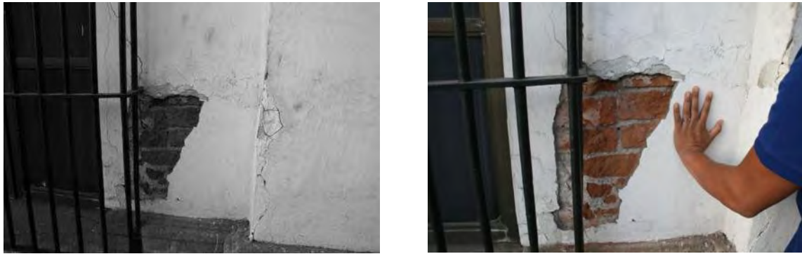
Figura 37. Fotografía de muro exterior del AHGES, donde se puede ver la mampostería de ladrillo rojo de barro cocido y el aplanado de mortero cal arena
