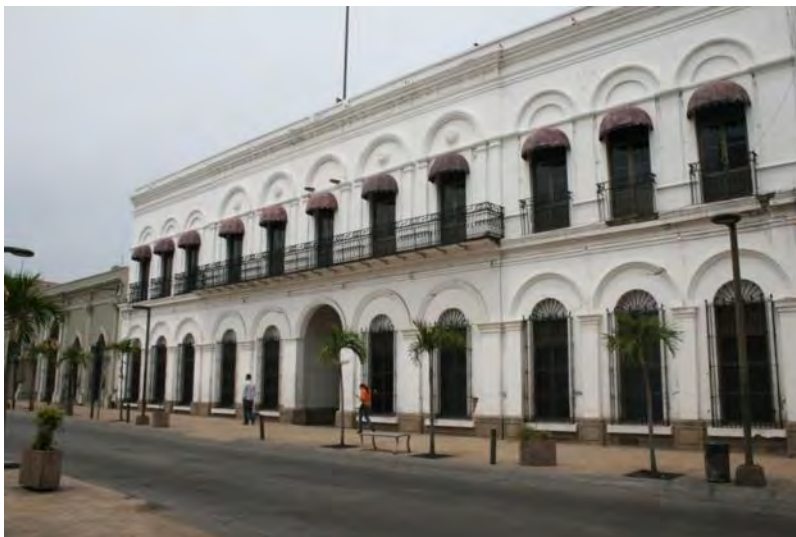
Figura 01 . Fachada principal del Archivo Histórico General del Estado de Sinaloa
