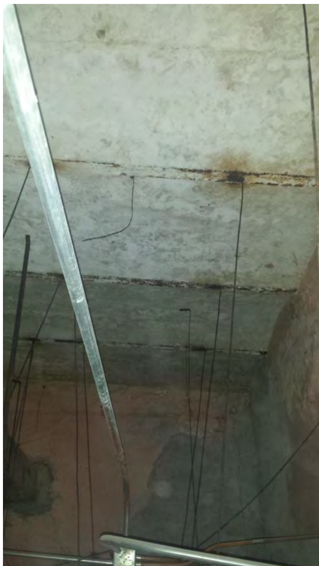
Figura 36. Fotografía de vigueta y bovedilla en capa interior de losa de azotea Fuente: Catalina Borbolla Gaxiola
