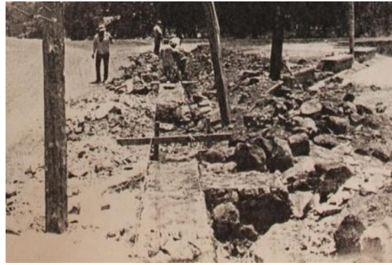
Figura 84. Construcción del muro atrial. Foto de Armando Paez
