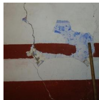
Figura 49. Pintura del interior del muro norte. Se observan algunas capas anteriores - foto tomada en Marzo de 2012 por Anyul Cuéllar
