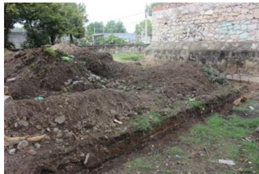
Figura 9012. Excavaciones para la construcción de un muro bajo para evitar los encharcamientos. Foto tomada en Marzo de 2012 por Anyul Cuéllar
