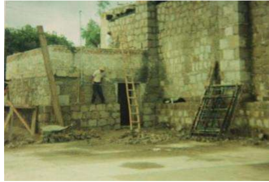
Figura 76. Vista de la Sacristía durante la intervención. Foto de Armando Paez
