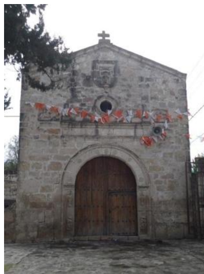
Figura 98. Fachada de la Capilla de Santiago. Foto tomada en Marzo de 2012 por Anyul Cuéllar
