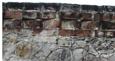
Figura 51. Remate de Sacristía en muro norte. Se observa el aparejo inglés pero con la segunda hilada en diagonal a manera de decoración - foto tomada en Marzo de 2012 por Deniss Castañeda
