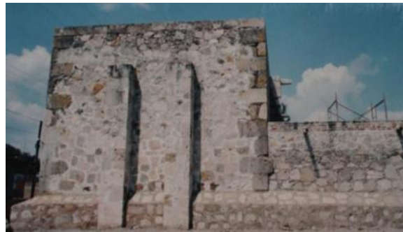
Figura 87. Vista del muro sur de la Capilla después de la reconstrucción. Foto de Armando Paez
