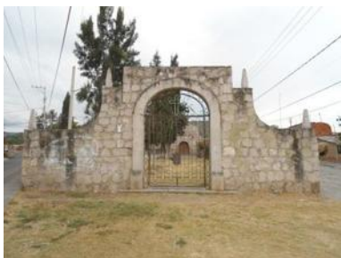
Figura 14 Acceso principal al atrio - foto tomada en Febrero de 2012 por Deniss Castañeda
