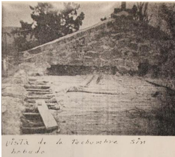
Figura 81. Vista de la cubierta durante los trabajos de reconstrucción: "Vista de la techumbre sin bóveda". Foto y leyenda de Armando Paez
