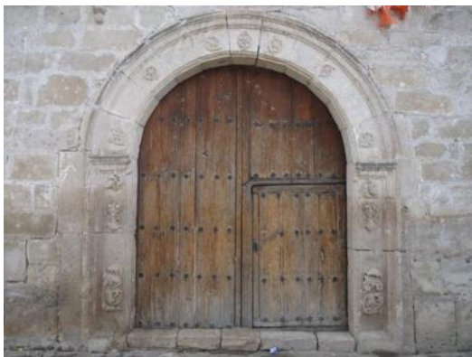
Figura 17 Acceso a templo. Se puede observar la presencia de decoraciones en algunas dovelas y en las jambas – foto tomada en Marzo de 2012 por Anyul Cuéllar
