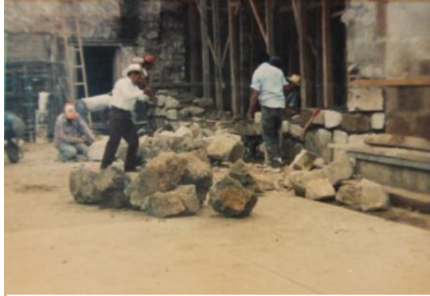
Figura 73. Durante los trabajos de reconstrucción del muro oriente. Foto de Armando Paez
