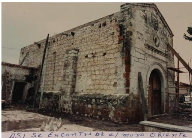
Figura 70. Vista de la capilla antes de la reconstrucción de 1993. Se observa el muro oriente con un solo contrafuerte más bajo y el "rodapié". En la Sacristía aún se observa la parte inferior en adobe y sin rodapié. Foto de Armando Paez.
