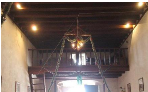
Figura 33. Vista general del Coro - foto tomada en Marzo de 2012 por Anyul Cuéllar
