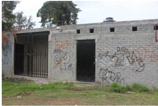
Figura 89. Anexo. Construcción de sanitarios. Foto tomada en Marzo de 2012 por Anyul Cuéllar
