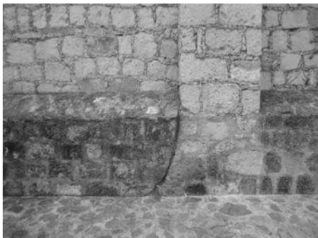
Figura 113. Muro este, ensanchamiento de muro y contrafuerte- foto tomada en Marzo de 2012 por Deniss Castañeda
