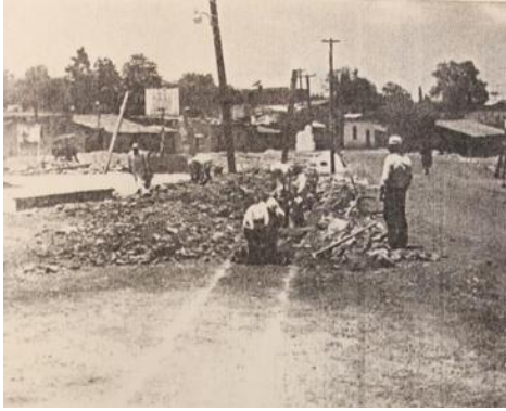
Figura 83. Marcas de cal que indican el lugar donde pasará el muro atrial. Foto de Armando Paez
