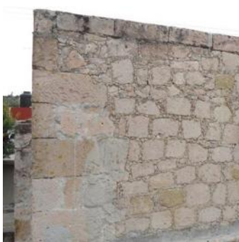
Figura 48. Acercamiento a la mampostería (muro exterior oriente) - foto tomada en Marzo de 2012 por Deniss Castañeda
