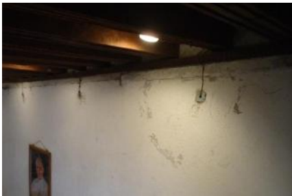
Figura 59. Vista de algunas instalaciones eléctricas visibles en la Nave – foto tomada en Marzo de 2012 por Anyul Cuéllar
