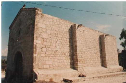
Figura 88. Vista general desde el poniente de la Capilla después de la reconstrucción. Foto de Armando Paez
