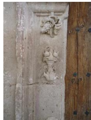
Figura 18 Jambas del acceso con restos de enlucido y pintura roja - foto tomada en Marzo de 2012 por Anyul Cuéllar
