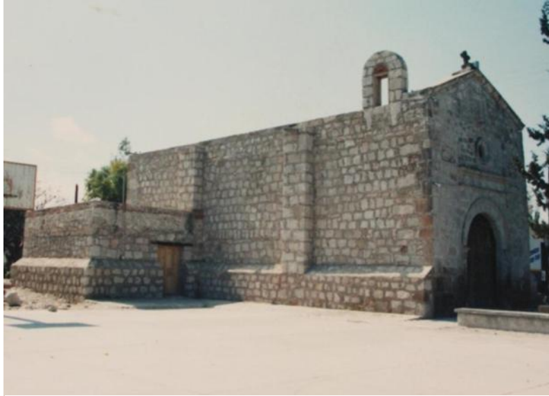
Figura 86. Vista de la Capilla desde el oriente después de los trabajos de reconstrucción. Foto de Armando Paez
