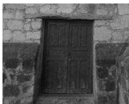
Figura 53. Acceso a Sacristía por el exterior - foto tomada en Marzo de 2012 por Deniss
