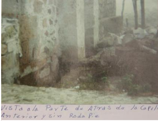
Figura 75. Excavaciones para la cimentación del rodapié. En la imagen se lee: "Vista a la parte de atrás de la capilla anterior y sin rodapie". Foto y leyenda de Armando Paez
