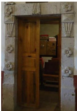
Figura 63. Puerta de acceso a la Sacristía por el Presbiterio - foto tomada en Marzo de 2012 por Anyul Cuéllar
