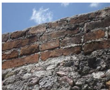
Figura 50. Remate de Sacristía. Ladrillo con aparejo inglés - foto tomada en Marzo de 2012 por Anyul Cuéllar
