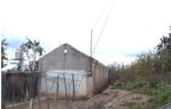
Imagen 28. Vivienda de piedra con aplanado. 52
