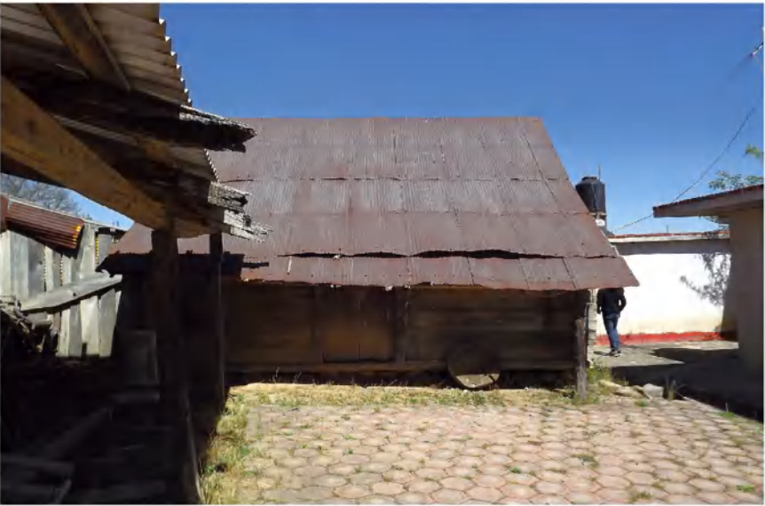
Imagen 3. Fachada sur del Troje.
