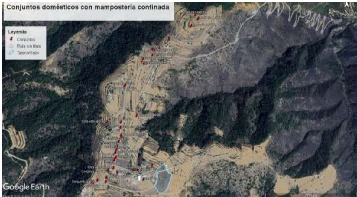
Figura 18. Conjuntos domésticos con mampostería confinada. 39
