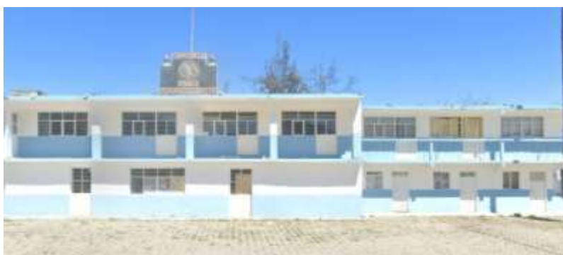
Imagen 17. Biblioteca y oficinas administrativas. 32
