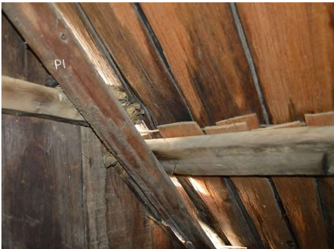
Imagen 62. Tejamaniles de cubierta
