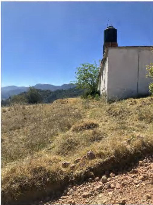
Imagen 9. Muros norte y este del conjunto.
