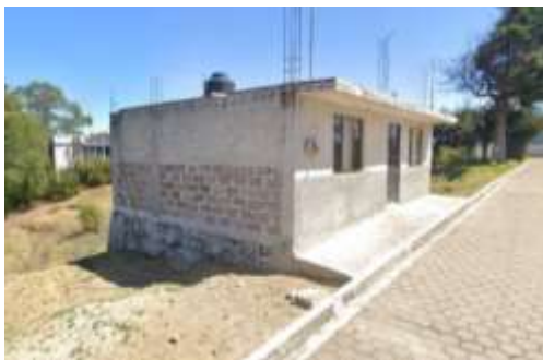
Figura 19. Vivienda 1 de mampostería confinada. 40
