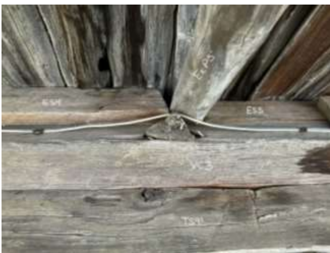
Imagen 46. Extensión de pares de tijerales para alero sur
