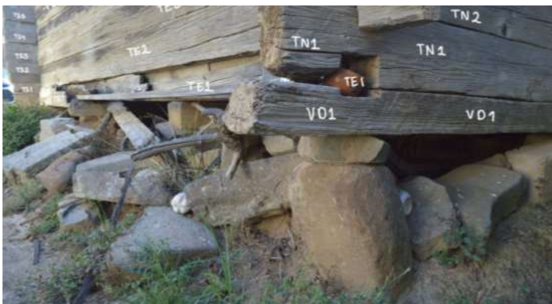
Imagen 51. Cimentación del troje
