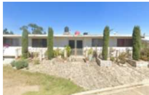
Figura 20. Vivienda 2 de mampostería confinada. 41
