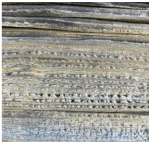
Imagen 42. Meteorización de la madera en el Troje de Tateno.
