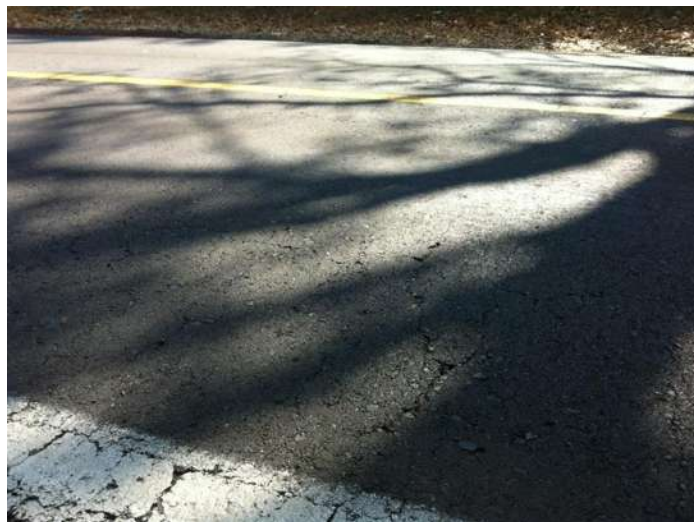
| Imagen 10. Superficie de Rodamiento Subtramo 2 (Quiroga - Carapan) Fuente: Elaboración Propia |
