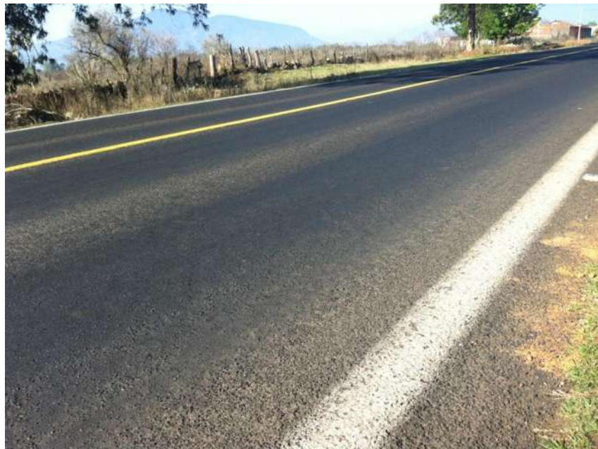
| Imagen 9. Superficie de Rodamiento Subtramo 1 (Morelia – Quiroga) Fuente: Elaboración Propia |
