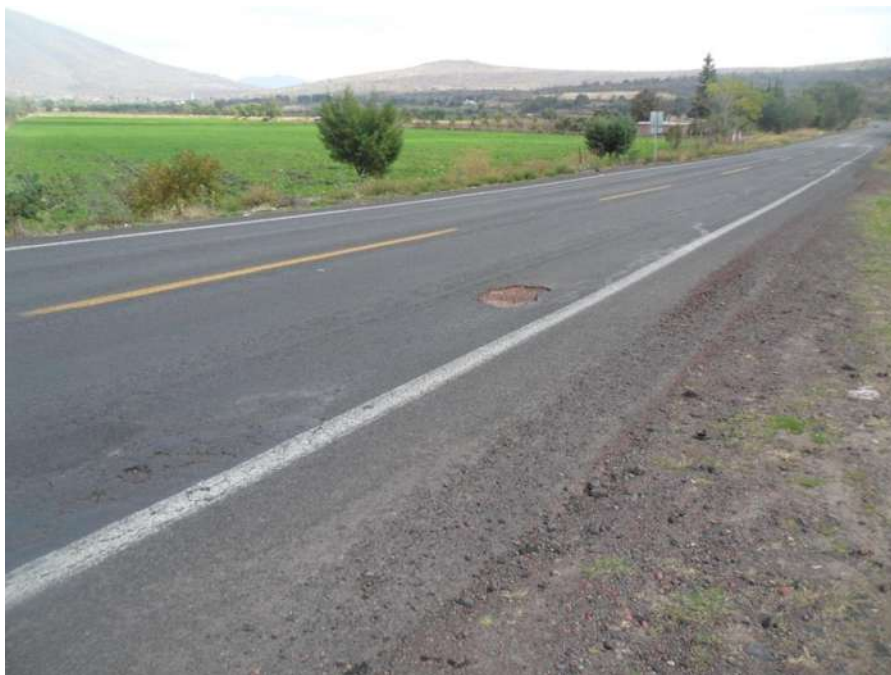
| Imagen 16. Bache Superficial Subtramo 4 Zamora – Jiquilpan Fuente: Elaboración Propia |
