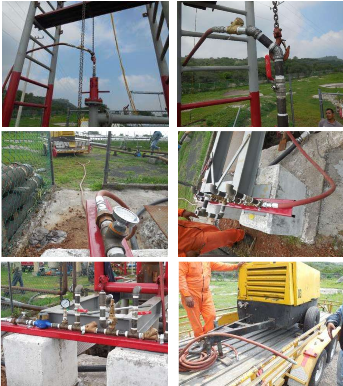
Figura 4.26. Conexión del sistema air-lift y sus componentes.
