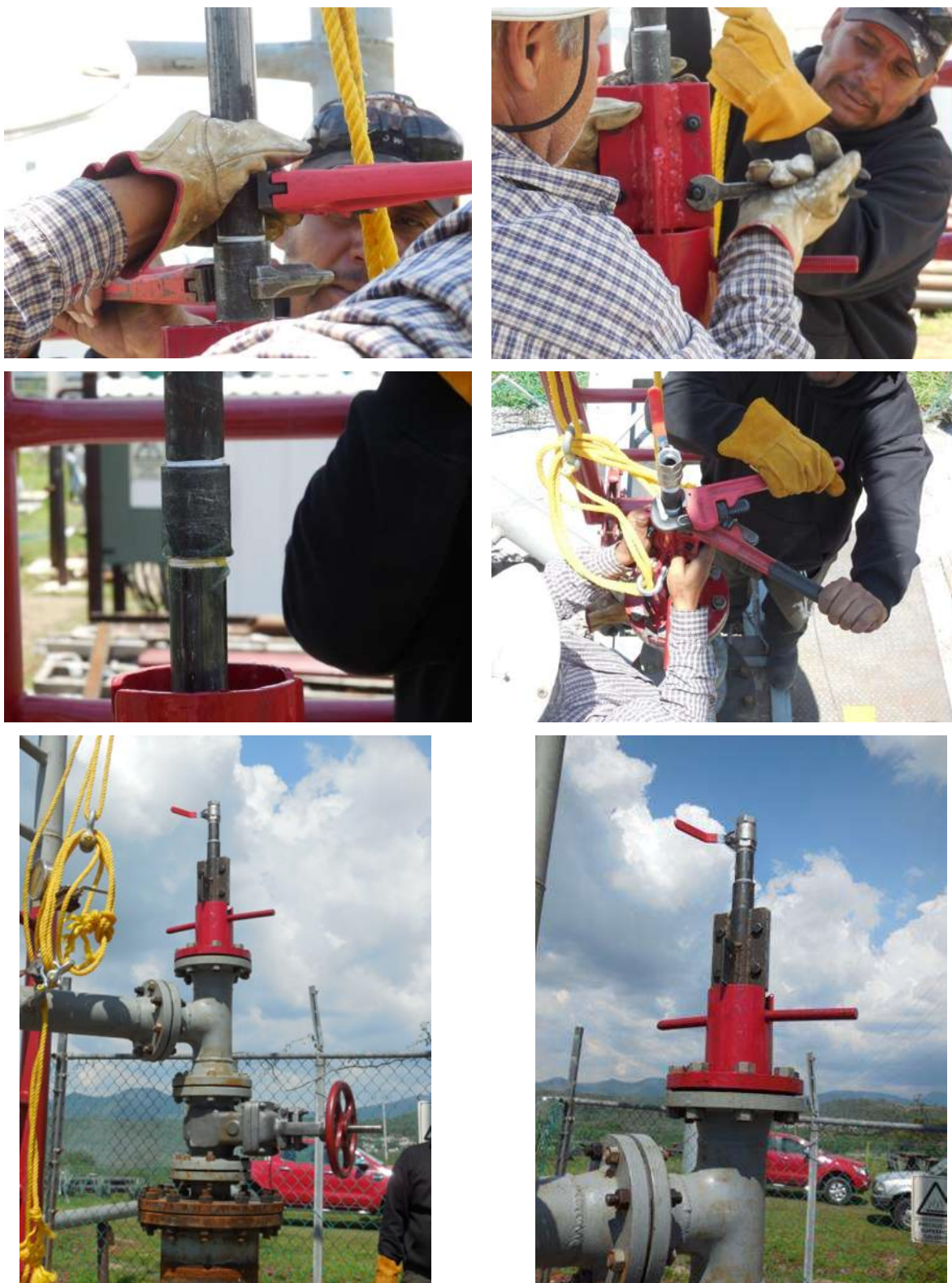
Figura 4.25. Trabajos para la inserción de la tubería de conducción de aire del sistema air-lift dentro del pozo geotérmico, (C).
