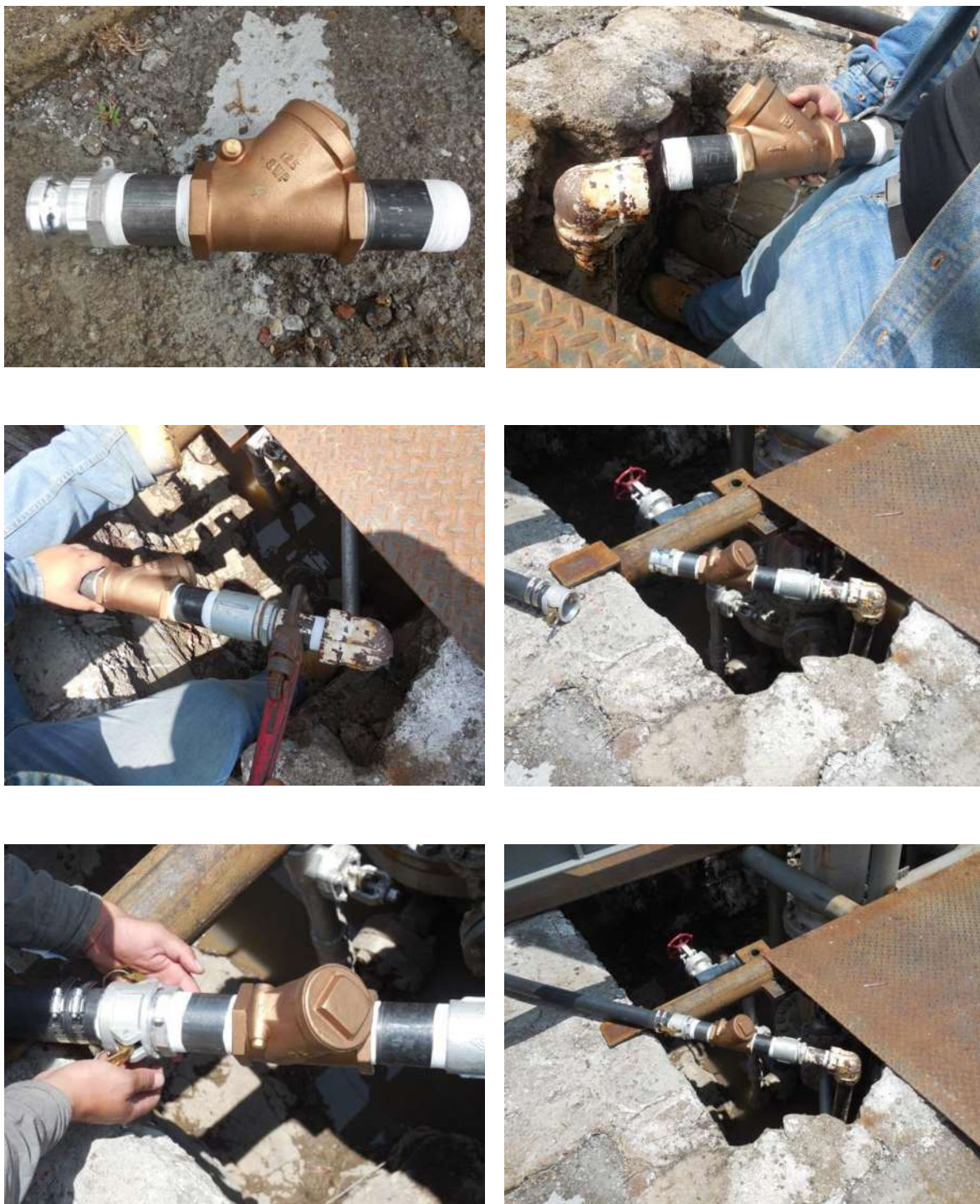
Figura 4.22. Preparación de los componentes para el mecanismo de apagado de pozo geotérmico.
