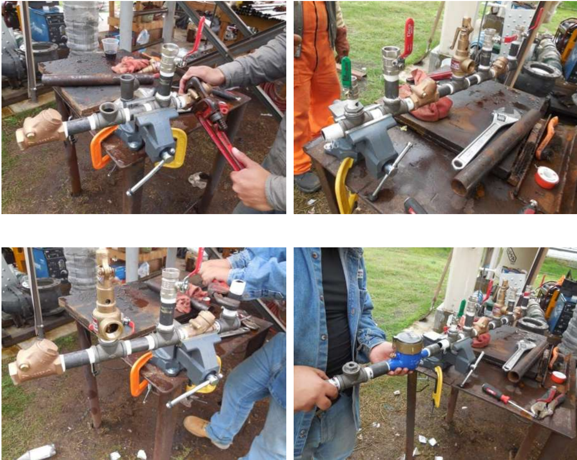
Figura 4.17. Colocación y roscado de los distintos elementos del tren de válvulas e instrumentos. (B).
