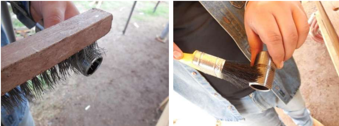
Figura 4.15. Limpieza de los componentes del tren de válvulas e instrumentos.
