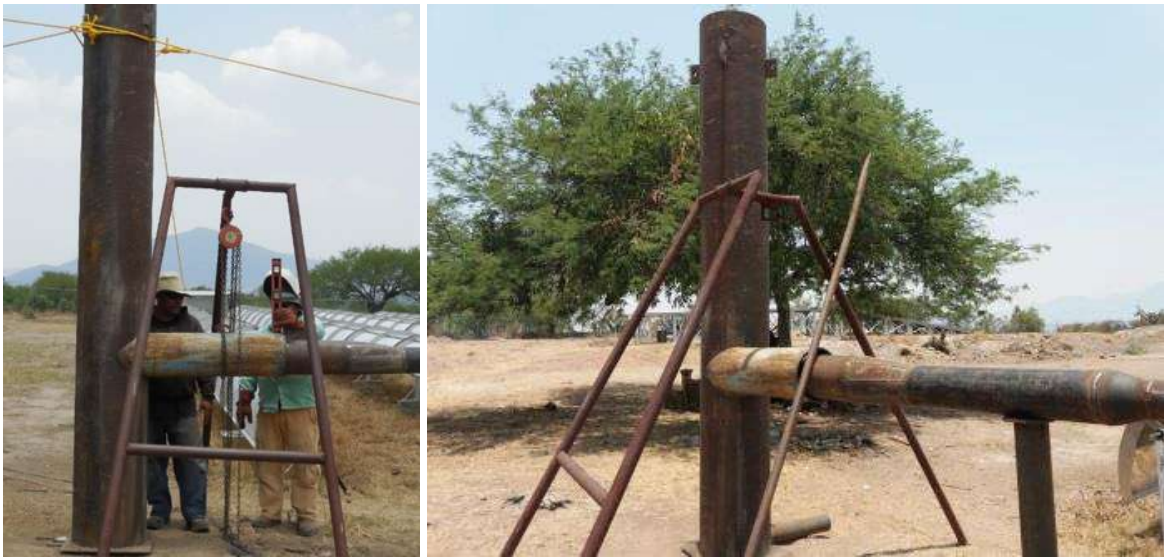
Figura 4.11. Acabado final del circuito de tuberías de recirculación con silenciador.
