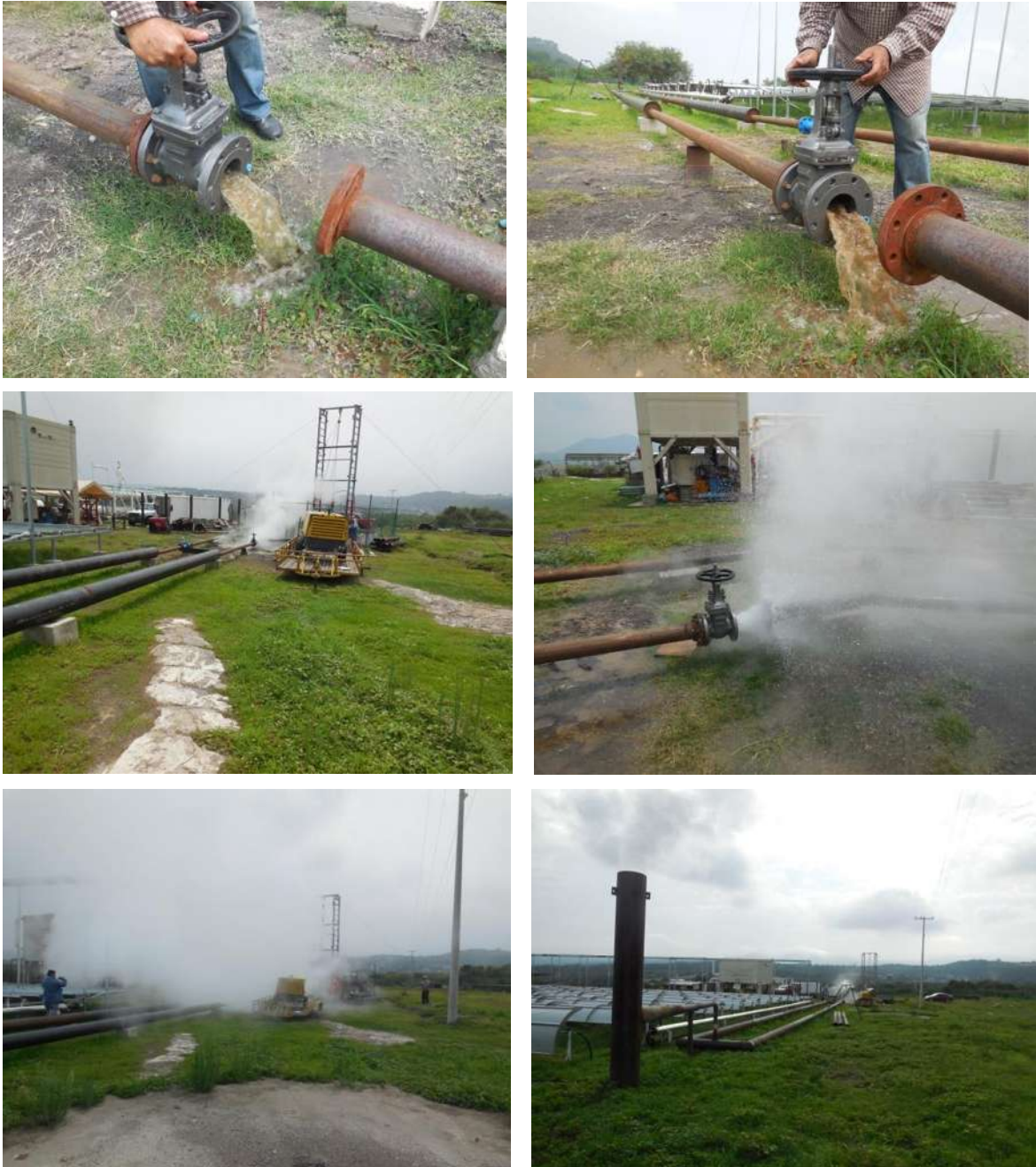
Figura 4.28. Labores de limpieza y arranque del sistema air-lift , B.
