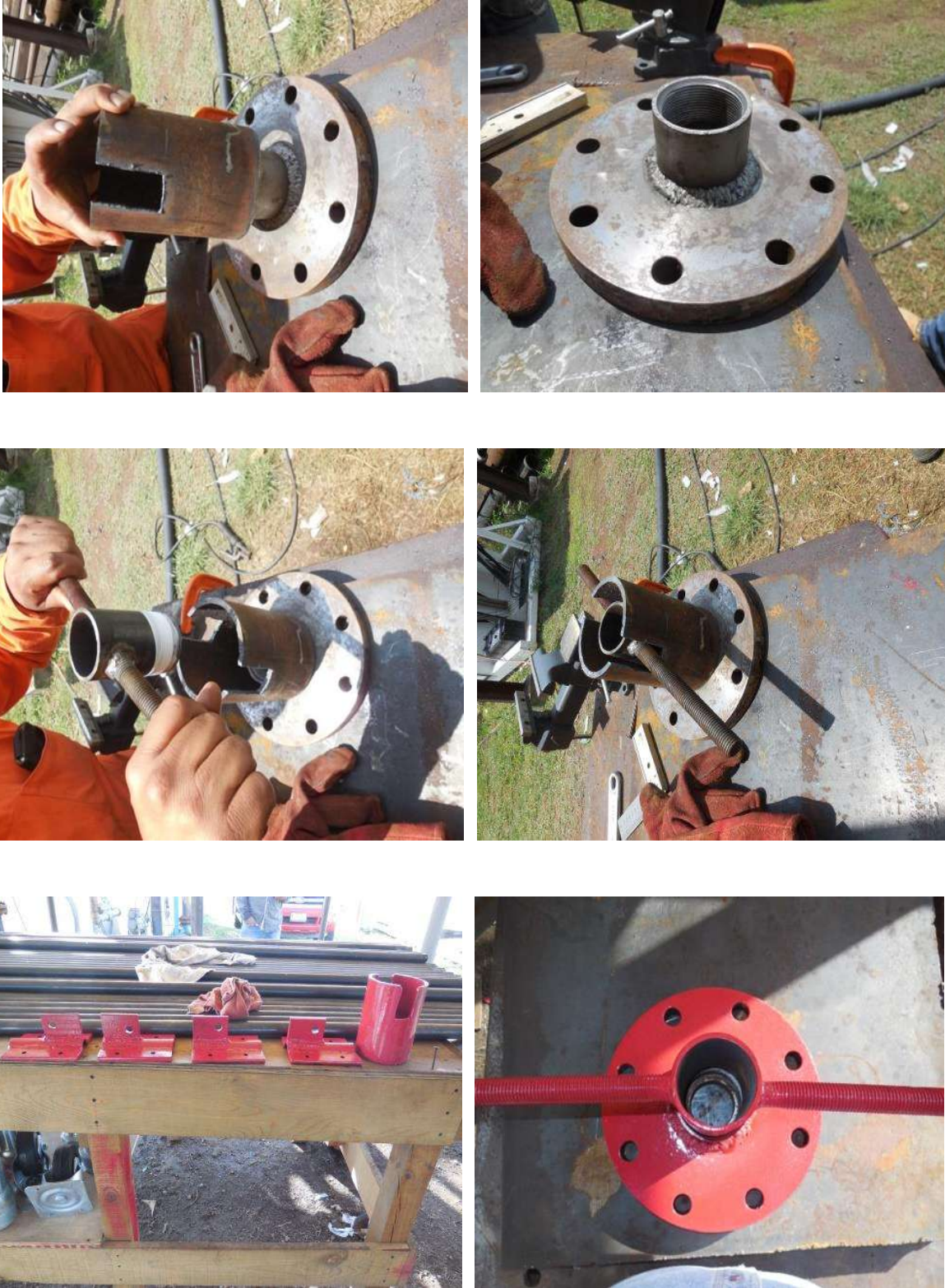
Figura 4.20. Construcción del prensaestopa, (B).
