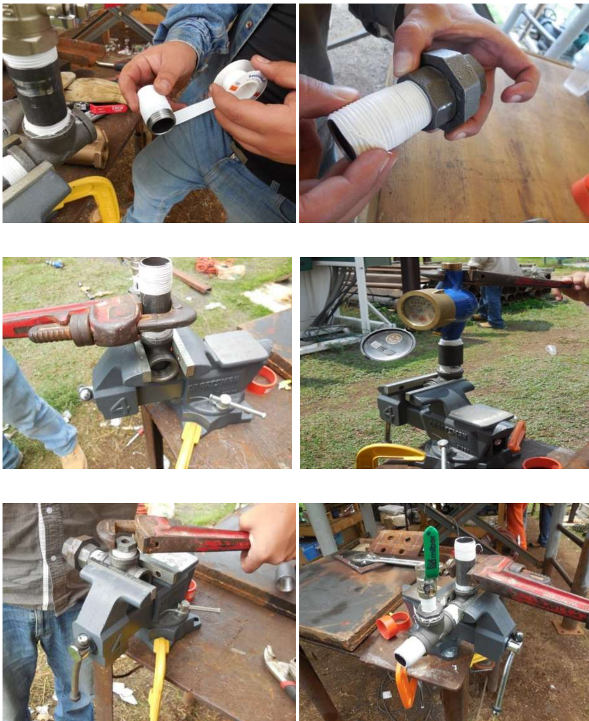
Figura 4.16. Colocación y roscado de los distintos elementos del tren de válvulas e instrumentos (A).
