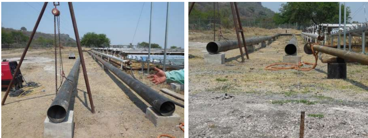
Figura 4.2. Colocación de la tubería sobre los soportes cimentados y alineación de la tubería de 10".
