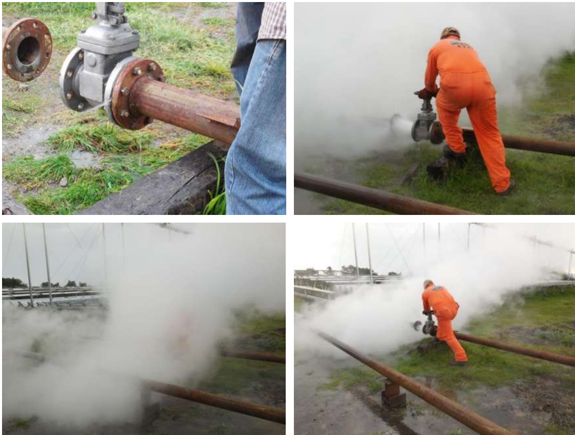
Figura 4.27. Labores de limpieza y arranque del sistema air-lift , (A).
