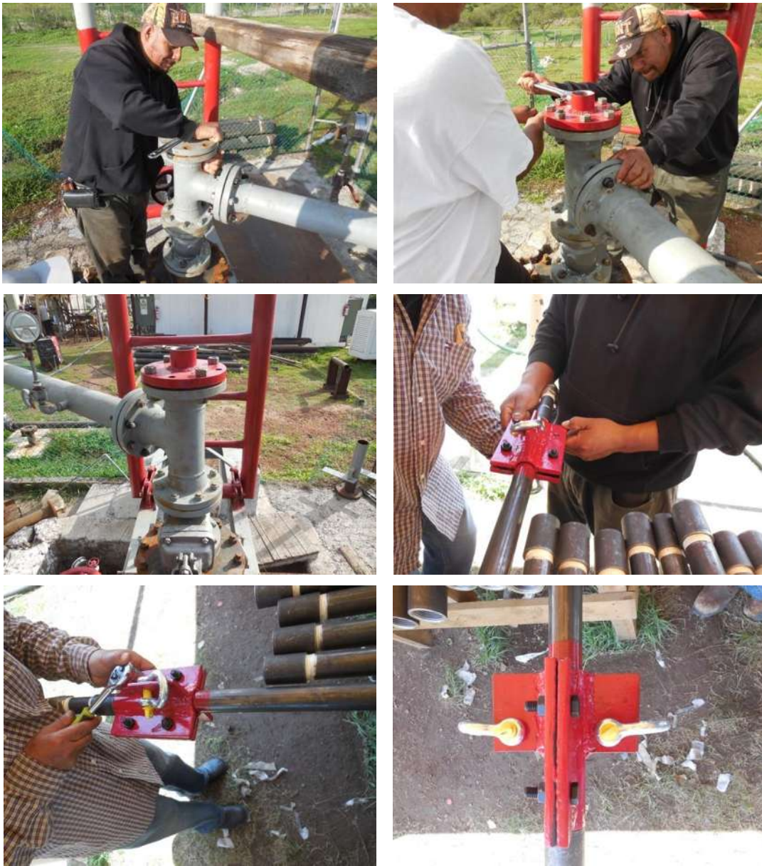
Figura 4.23. Trabajos para la inserción de la tubería de conducción de aire del sistema air-lift dentro del pozo geotérmico, (A).
