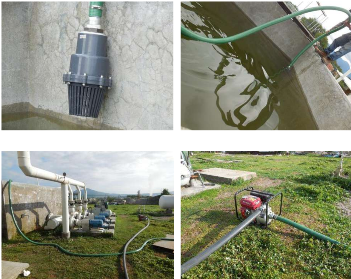
Figura 4.21. Inserción de la pichancha con la manguera de succión dentro de la pileta de agua fría
