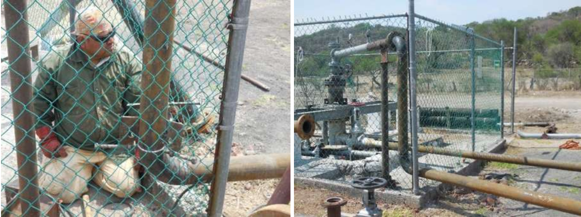
Figura 4.5. Ajuste de la tubería de 4" con el cabezal de válvulas. (Entrada y salida del cabezal de válvulas).
