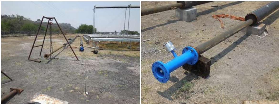
Figura 4.4. Alineación y medición de la tubería de 4” con la tubería de 10”.
