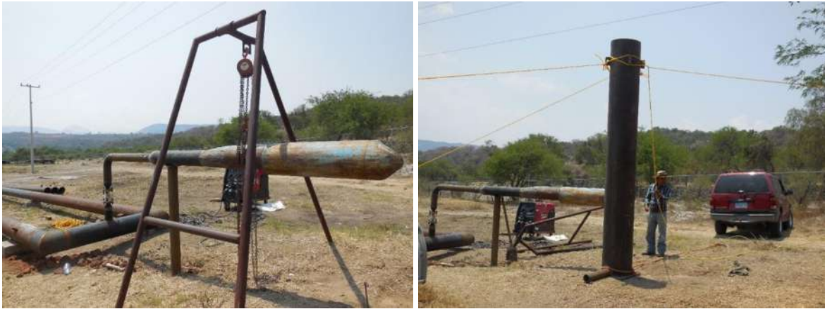
Figura 4.10. Montaje del silenciador y conexiones en el circuito de tuberías de recirculación.
