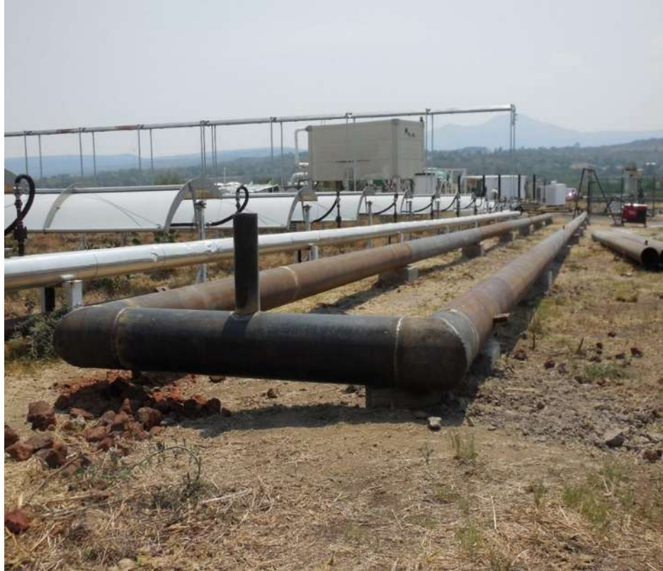
Figura 4.3. Unión completa de la tubería de 10”.
