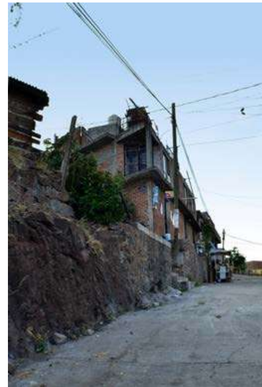
ILUSTRACIÓN 74 Calles col. Rincón del Punhuato (5) Elaboración propia (2020)
