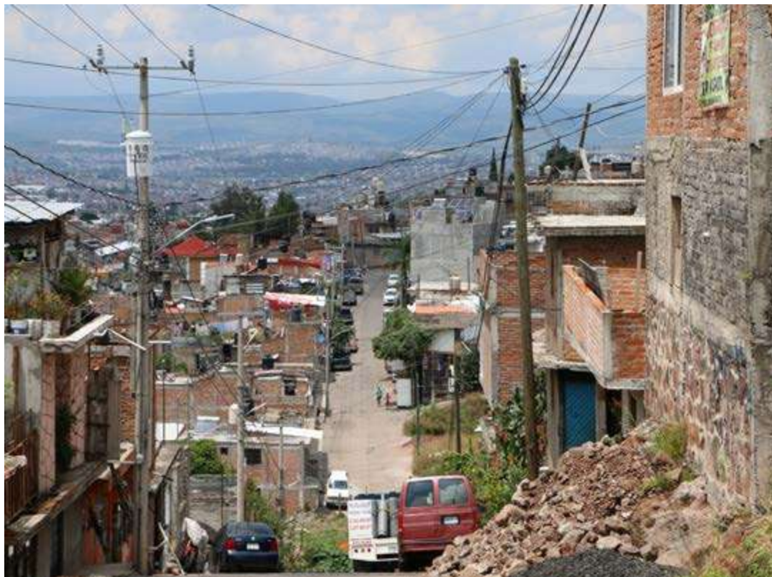
ILUSTRACIÓN 72 Calles col. Rincón del Punhuato (2) Elaboración propia (2020)
