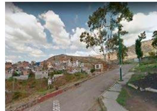
ILUSTRACIÓN 32 Zona de riesgo por inundación y derrumbe, 2015. Elaboración propia con información de Google Street (b) (sf)
