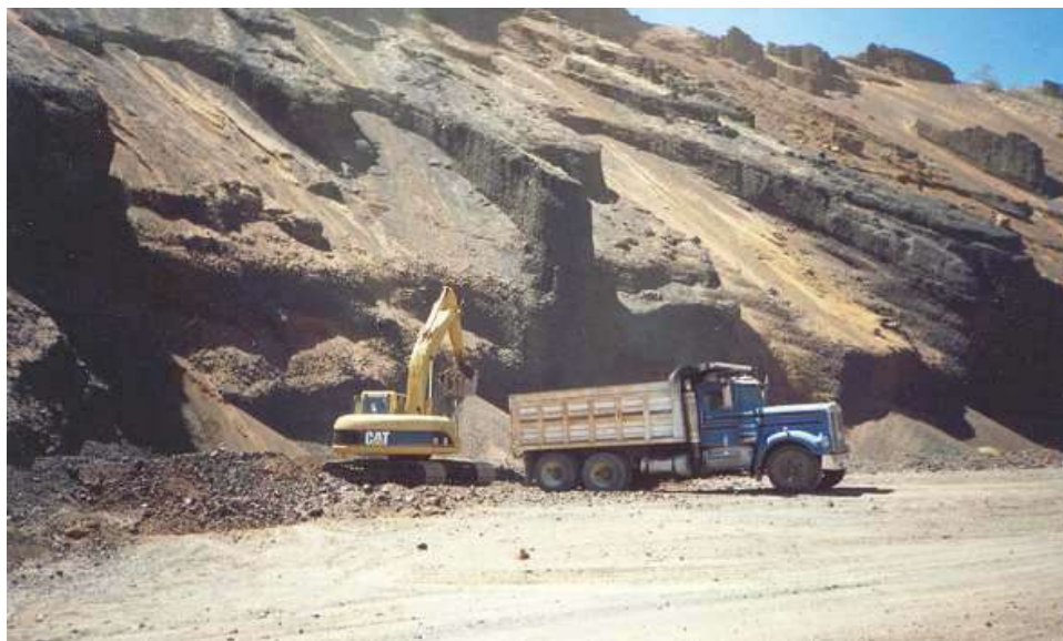
Figura 8. Extracción de los agregados pétreos utilizados en la elaboración del concreto hidráulico, Banco de Materiales Joyitas.
