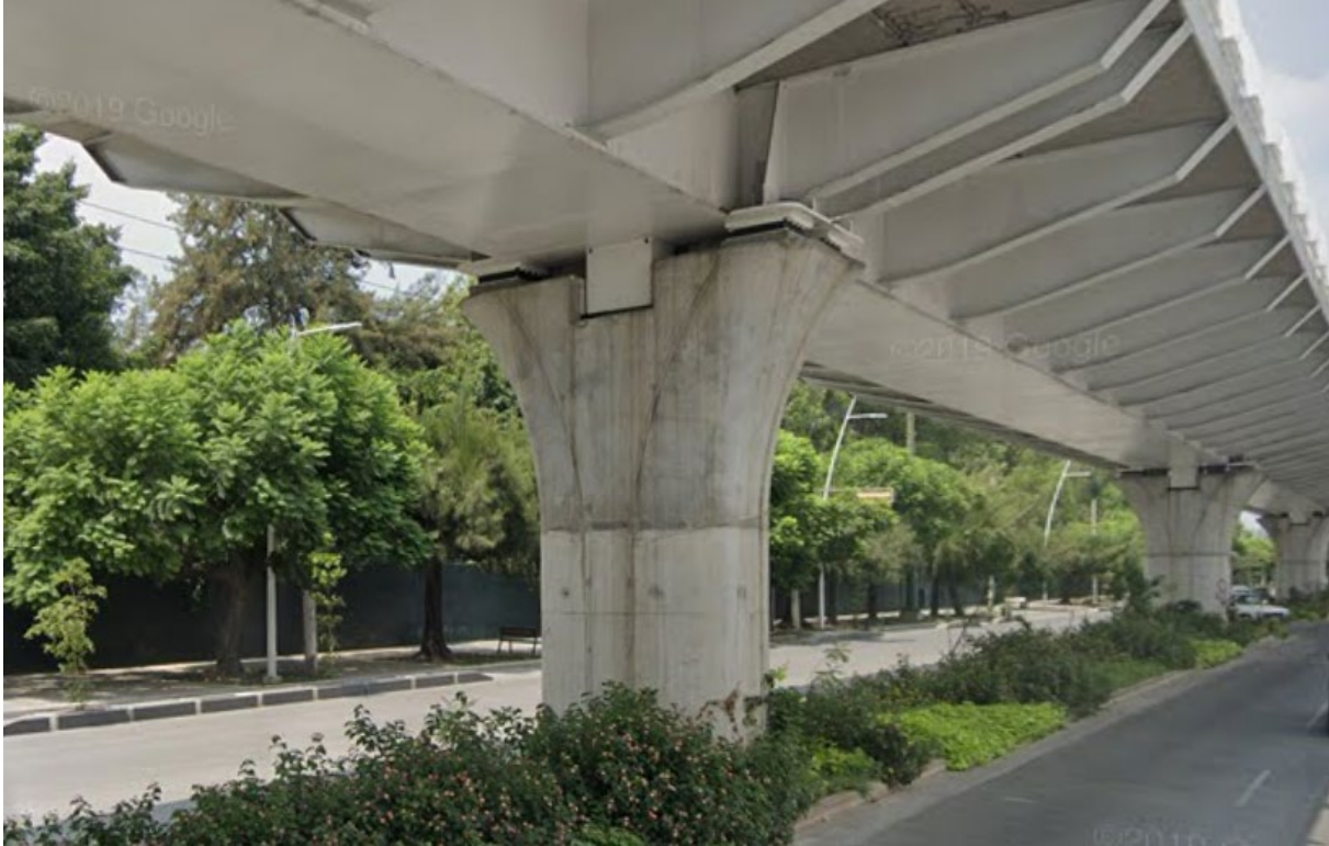
Figura 24. Columna del viaducto en la Av. Manuel Ávila Camacho [40].
