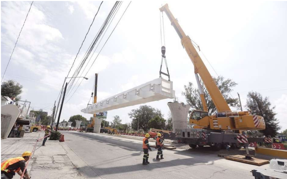
Figura 23. Ejecución del proyecto de la Línea 3 del tren ligero [39].
