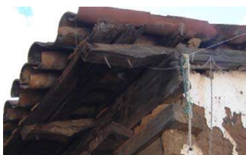
Imagen 49.- Detalle de clavacotes.
