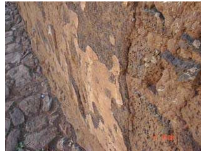
Imagen 42.- Aplanados de arcilla con restos de pintura.
