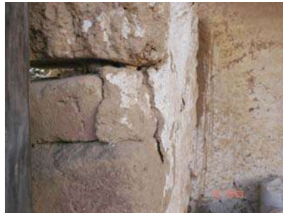
Imagen 41.- Aplanados de arcilla con restos de pintura.
