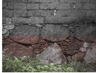
Imagen 63.- Detalle de materiales en muro y cimentación.
