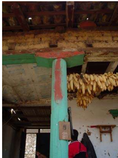
Imagen 44.- Columnilla de madera circular.
