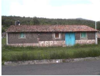
Imagen 62.- Aspecto formal de la fachada.
