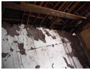
Imagen 64.- Detalle interior de cubierta y muro
