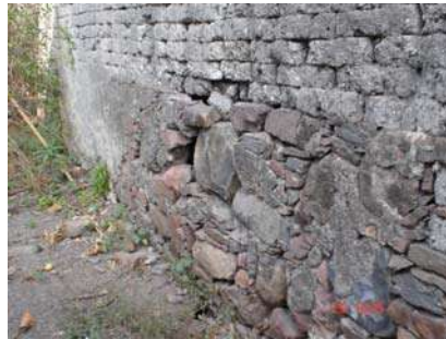
Imagen 35.- Sobre cimiento de mampostería.
