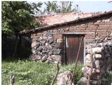
Imagen 66.- Detalle de cubierta
