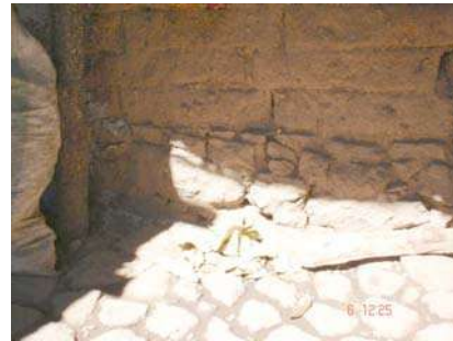
Imagen 36.- Sobre cimiento de mampostería.
