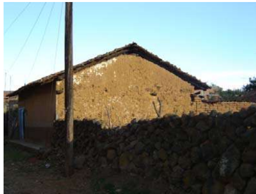
Imagen 50.- Cubierta a dos aguas
