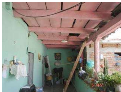
Imagen 47.- Plafón fabricado a base de tabla y vigeria.
