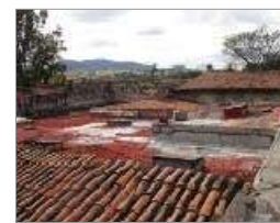
FOTO 38 / FACADIA EXTERIOR / VISTA LATERAL AUTOPRODUCIBLE, FOTOGRAFADO SANCHEZ FECHA DEL 2017
