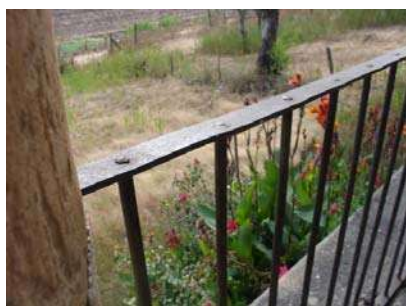
Ilustración 71 Diversas Imágenes de los materiales en la edificación
