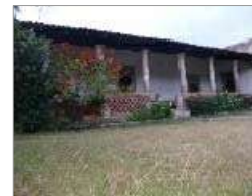
FOTO 40 / FACADIA EXTERIOR / VISTA LATERAL AUTOPRODUCIBLE, FOTOGRAFADO SANCHEZ FECHA DEL 2017
