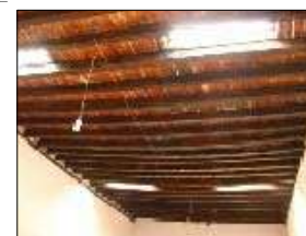
FOTO 01: CUBIERTA VISTA PARCIAL DE ALTERACIONES DE METAL ALACERADO
