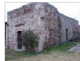
FOTO 37 / FACADIA EXTERIOR / VISTA LATERAL AUTOPRODUCIBLE, FOTOGRAFADO SANCHEZ FECHA DEL 2017
