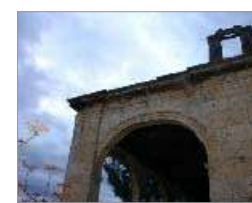
FOTO 41 / PORTAL / VISTA EXTERIOR DE OPORTUNIDAD AUTOPRODUCIBLE, FOTOGRAFADO SANCHEZ FECHA DEL 2017
