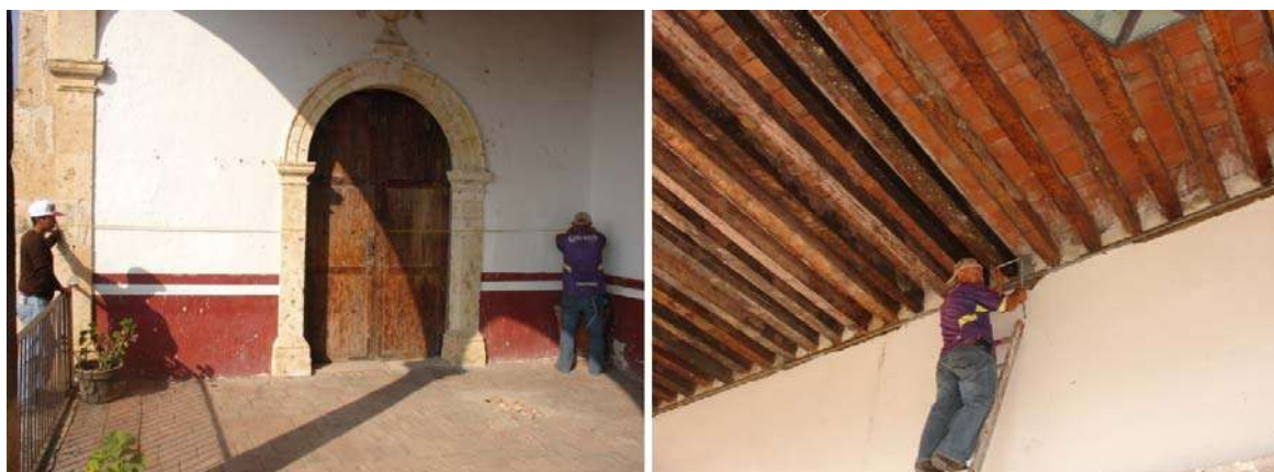
Ilustración 30, Trabajos a cinta corrida del levantamiento arquitectónico y medición de vigería, Autor:Gabriel Mercado Sánchez, Diciembre 2013
