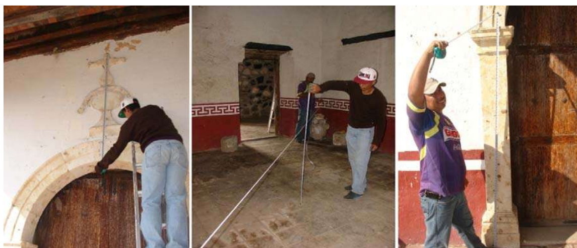
Ilustración 31, Medición de molduras y obtención de niveles en los trabajos del levantamiento arquitectónico, Autor:Gabriel Mercado Sánchez, Diciembre 2013
