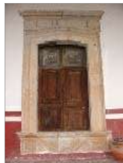
FOTO 31 / PORTAL / VISTA VANO DE VENTANA AUTOPRODUCIBLE, FOTOGRAFADO SANCHEZ FECHA DEL 2017
