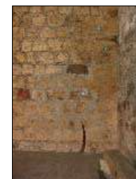
FOTO 04: SALON VISTA PARCIAL DE ALTERACIONES DE METAL ALACERADO
