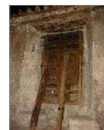
FOTO 10 / LOCAL 4 / VISTA VANO DE VENTANA AUTOPRODUCIBLE, FOTOGRAFADO SANCHEZ FECHA DEL 2017
