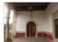
FOTO 1 / PORTAL / VISTA PARCIAL DEL PORTAL AUTOPRODUCIBLE, FOTOGRAFADO SANCHEZ FECHA DEL 2017
