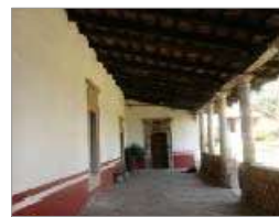
FOTO 33 / CORRIDOR / VISTA FRONTAL AUTOPRODUCIBLE, FOTOGRAFADO SANCHEZ FECHA DEL 2017
