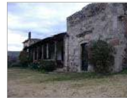
FOTO 36 / FACADIA EXTERIOR / VISTA LATERAL AUTOPRODUCIBLE, FOTOGRAFADO SANCHEZ FECHA DEL 2017
