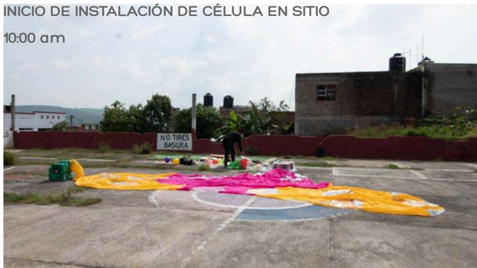
Instalación de célula en cancha Pino Suárez [2020]
