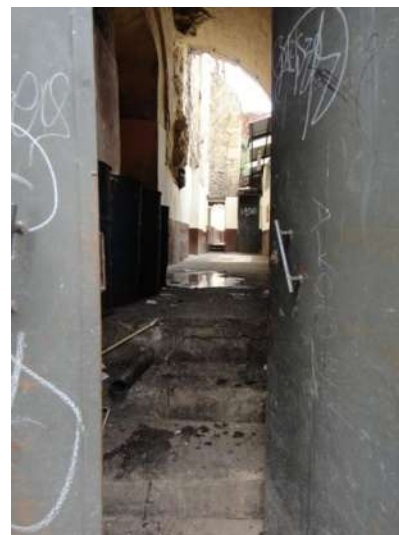
Ilustración 29. Estado actual de conservación del convento Santa María de Gracia, puerta lateral de la casa de estudiante "J. Isaac Arriaga", Morelia 2014
