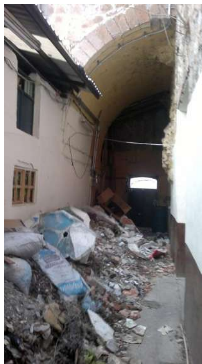
Ilustración 32. Estado actual de conservación del convento Santa María de Gracia, puerta lateral de la casa de estudiante "J. Isaac Arriaga", Morelia 2014
