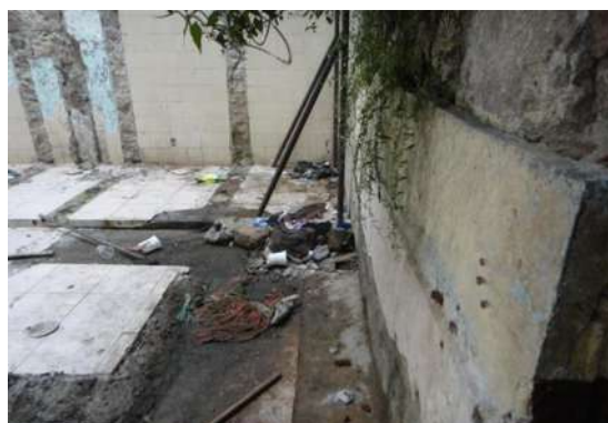
Ilustración 39. Estado actual de conservación del convento Santa María de Gracia, actual casa de estudiante "J. Isaac Arriaga", Morelia 2014
