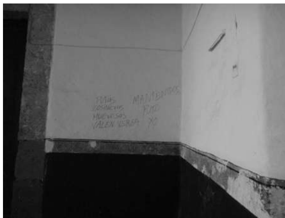
Ilustración 40. Estado actual de conservación del convento Santa María de Gracia, actual casa de estudiante "J. Isaac Arriaga", Morelia 2014
