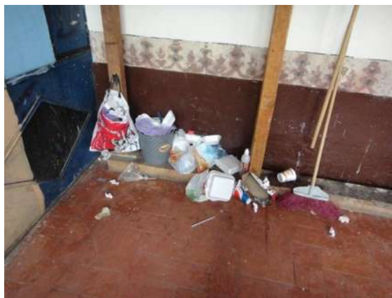
Ilustración 30. Estado actual de conservación del convento Santa María de Gracia, actual casa de estudiante "J. Isaac Arriaga", Morelia 2014
