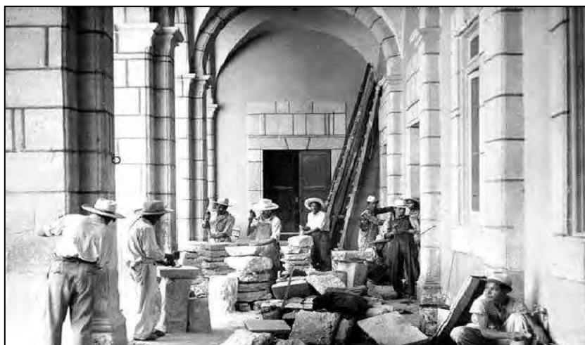
IMAGEN I.6.3.1.a.- Reposición de piezas talladas en cantería, en el piso del palacio de Gobierno, alrededor del año de 1947. Fuente fotográfica San Luis en el siglo XIX. https://www.facebook.com/San-Luis-En-El-Siglo-XIX-658771557492176/?fref=photo .
