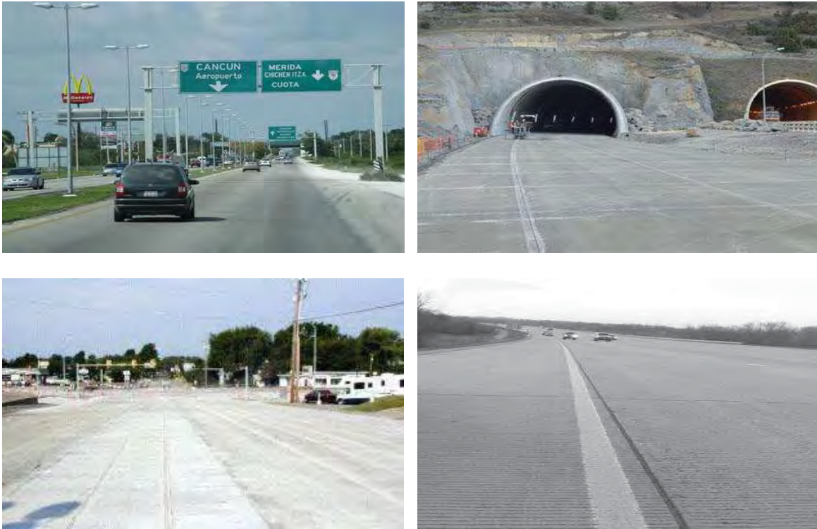
Figura 2.14 a, b, c y d. Carreteras elaboradas en la actualidad en México con concreto hidráulico.
