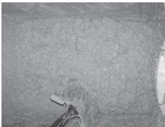
Fotografías 5.65 a y b. Elaboración y colado de la mezcla de Nanoconcreto GP – 50%MAR TI, 50%GR2-3, 5%NEU#80, CH de 15x15x60cm.
