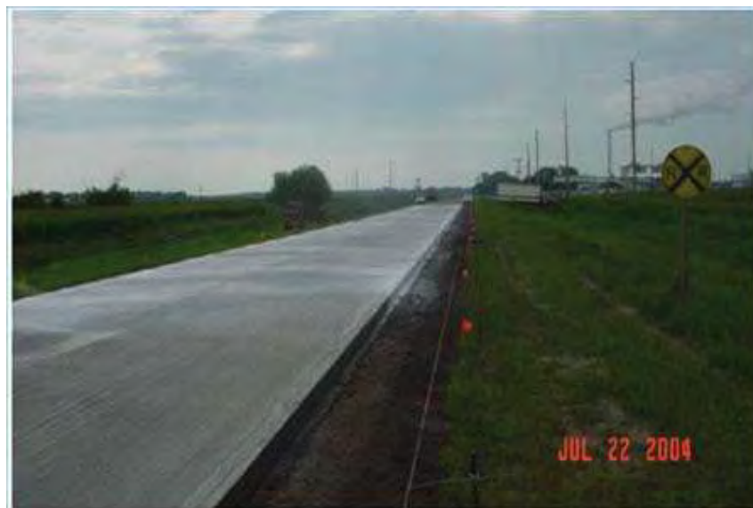
Figura 2.16. Sobrecarpeta whitetopping aplicada en una carretera en Nebraska.
