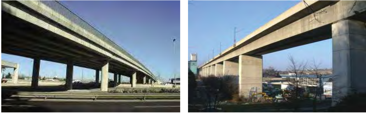
Figura 2.17 a y b. Puentes de concreto reforzado.
