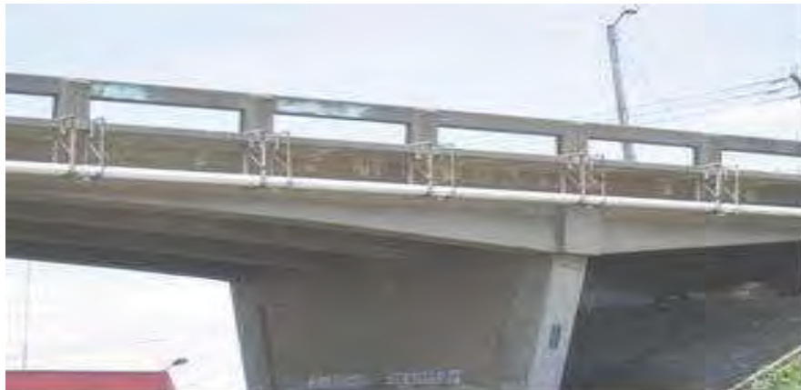
Figura 2.21. Apoyo rígido (concreto).
