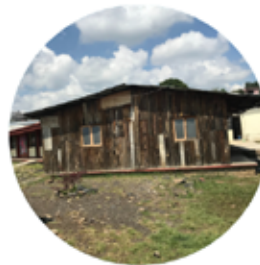
6 aulas de palitos y 2 talleres
