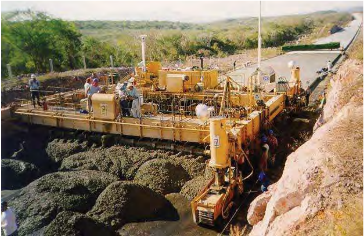
Figura 2.16. Introducción – Tecnología – Pavimentadora de Cimbra Deslizante
