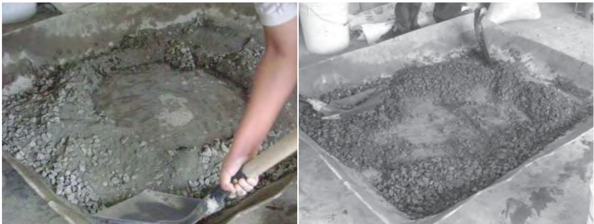
Figura 4.7. Mezclado en húmedo
