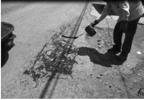
Paso 3, vaciado de emulsión
