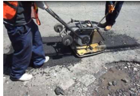
Paso 6, compactado de la mezcla
