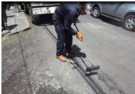
Paso 1 del bacheo, limpieza
