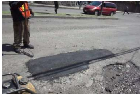
Paso 7, fin de bacheo
