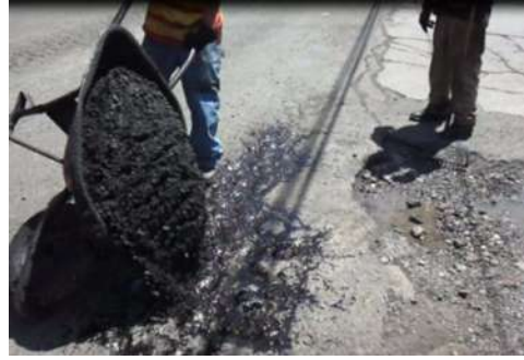
Paso 4, vaciado de la mezcla
