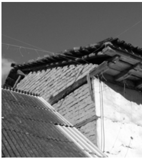
Figura: 25 Detalle de cubierta casa habitación Tancítaro. Víctor Lora Hurtado 2004.
