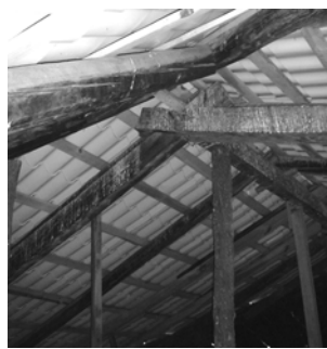
Figura: 27 Detalle cubierta capilla del Hospital, Tancítaro. Leonardo Hernández L. 2004.
