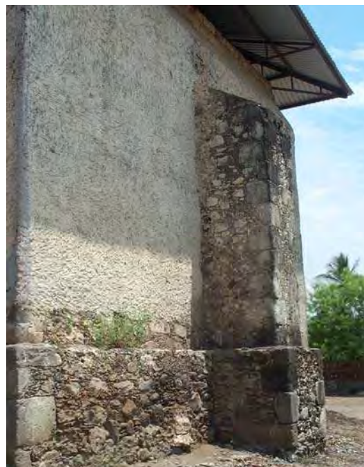
Figura: 32 Contrafuerte muro testero templo Santa Ana Amatlán. Teresita Valle González
