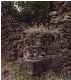
Figura: 45 Detalle traslape de muros en las esquinas de la capilla. Teresita Valle G. Mayo 2004.
