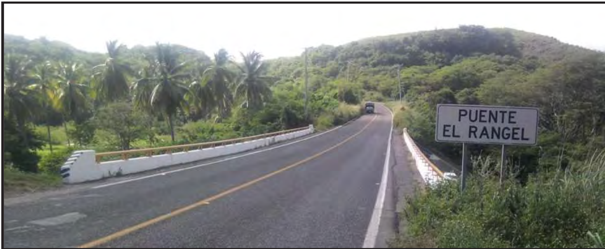
Foto VI.2 Puente “El Rangel” vista Este-Oeste (30/SEP/2010).
