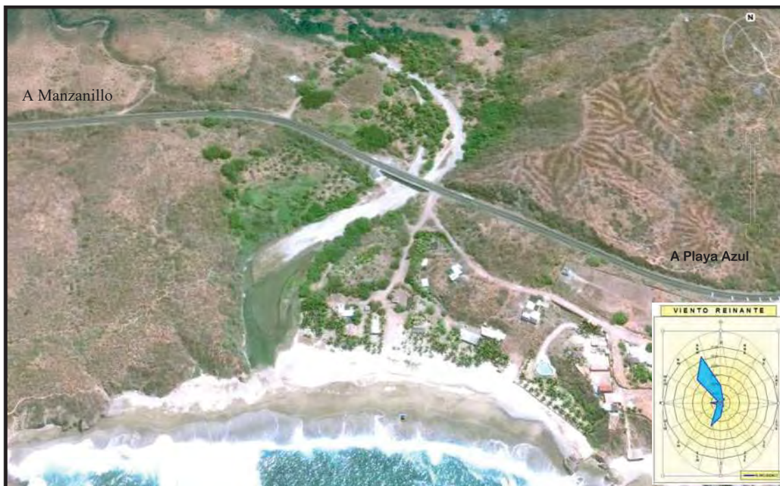
Foto VI.1 Panorámica Puente “El Rangel” ubicado en el Municipio de Lázaro Cárdenas, estado de Michoacán [14]. Rosa de Vientos Dominantes [15].
