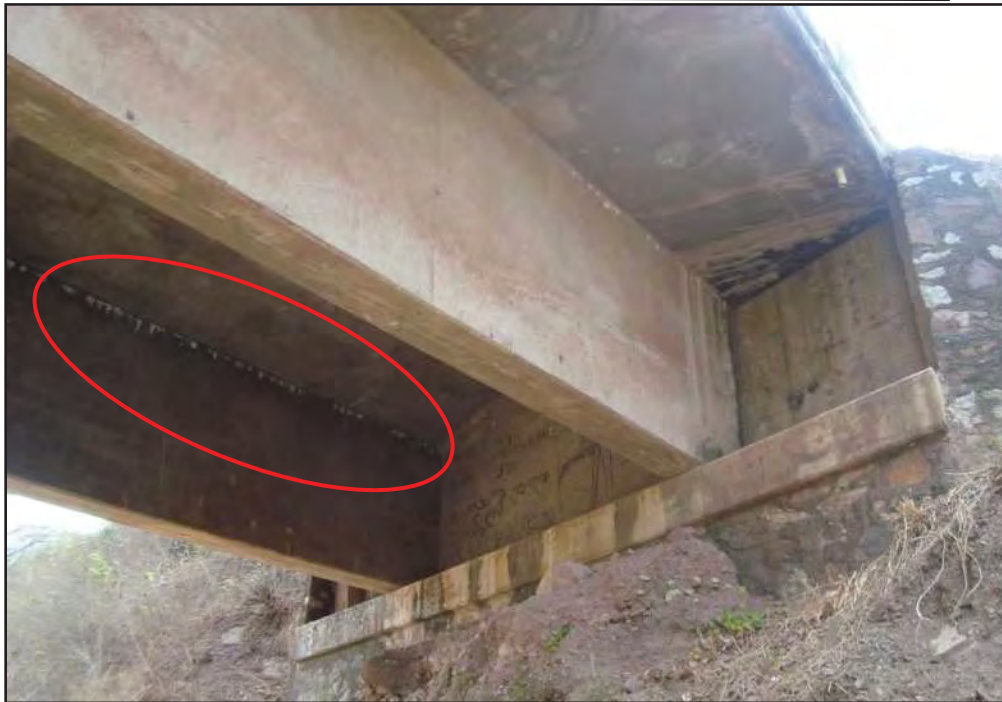
Foto VIII.6.- Estribo Derecho Cara Este Inferior (31/MAR/2011).
