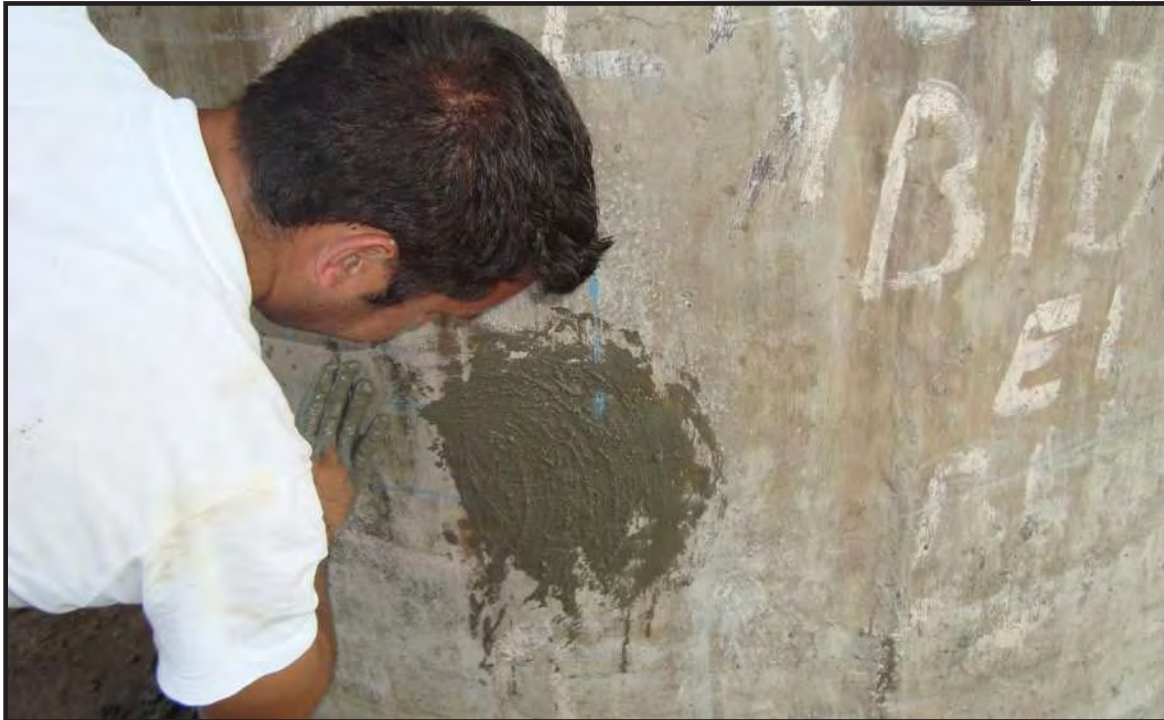
Foto VII.7 Ejemplo de Relleno con mortero por la extracción del núcleo. (03/JUN/2011).
