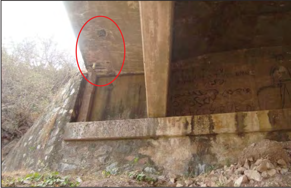
Foto VIII.4.- Estribo Derecho Cara Este Inferior (31/MAR/2011).
