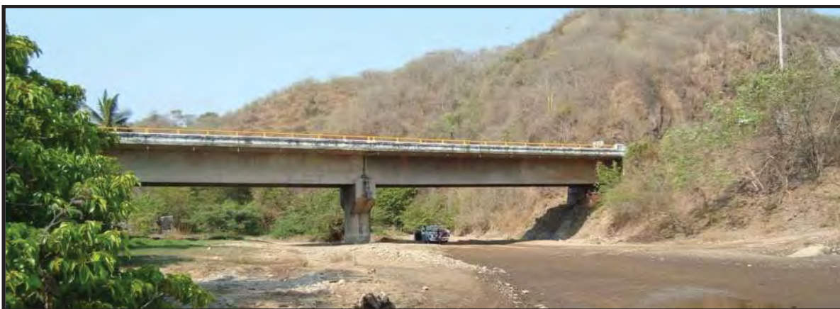
Foto VI.3 Puente “El Rangel” vista Sur-Norte (03/JUN/2011).
