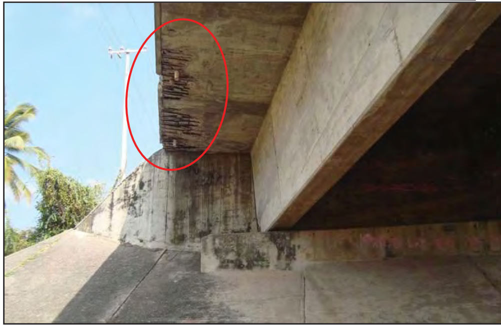
Foto VIII.8.- Estribo Izquierdo Cara Oeste (03/JUN/2011).
