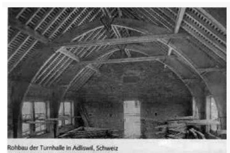
Figura 2. Arcos de madera laminada, inicios del proceso de laminación de madera, recuperado de t.ly/ta-D
