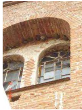
Imagen 3.30 Vanos de la nave
