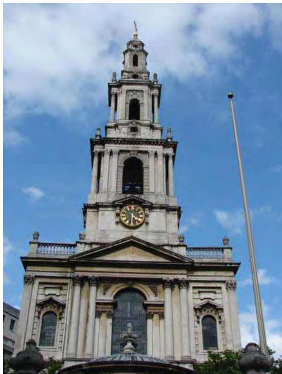
Imagen 2.21 FACHADA SAINT MARY LE STRANDS (Londres, 1724)
