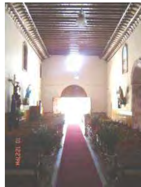
Imagen 3.37 VISTA INTERIOR DEL ACCESO
