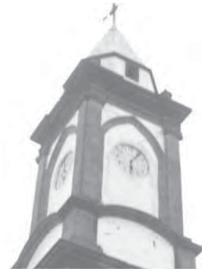
Imagen3. 44 DETALLE DE LA TORRE
