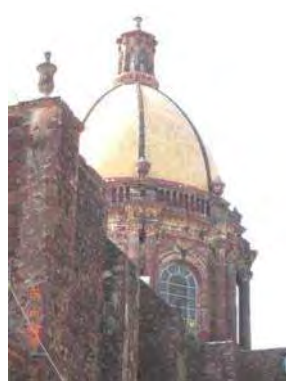
Imagen 3.5 CÚPULA VISTA EXTERIOR
