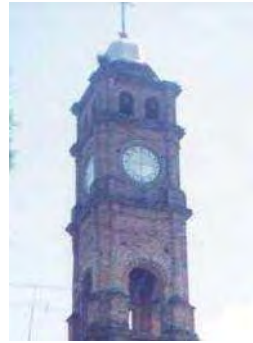
Patamban (pérdida total)
