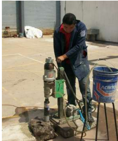
Figura N°50. Equipo de extracción de corazones (Fuente M. A. Navarrete Seras).
