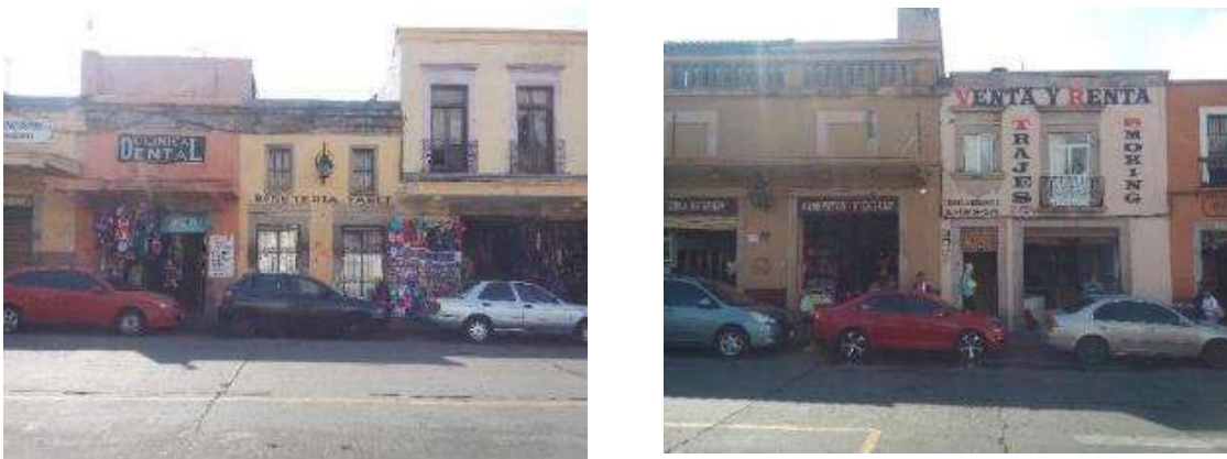
Figura 40 y 41.- Fachada de locales comerciales en la calle Humboldt. Imagen tomada por Gabriel Cortés Mancera, [15/01/19].
