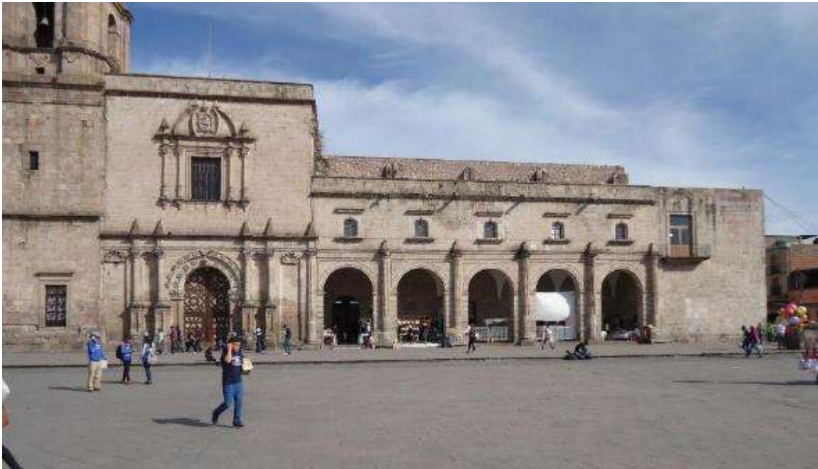
Figura 76.- Fachada a intervenir del conjunto conventual San Francisco. Imagen tomada por Gabriel Cortés Mancera, [10/01/19].
