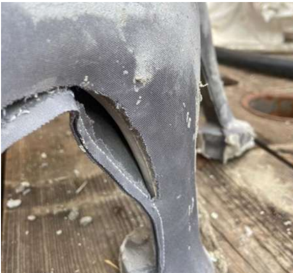
Figura 92: Concreto fraguando en cimbra de Vinipiel, elaboración propia.
