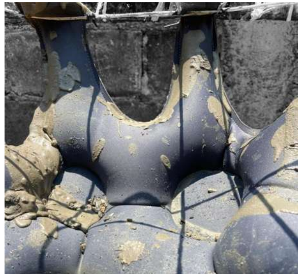
Figura 91: Descimbrado de la pieza de concreto y pliegues obtenidos, elaboración propia.
