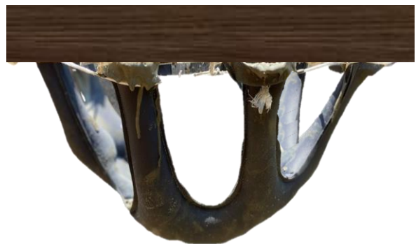
Figura 89: Cimbra de Vinipiel afectada por peso de la mezcla, elaboración propia.
