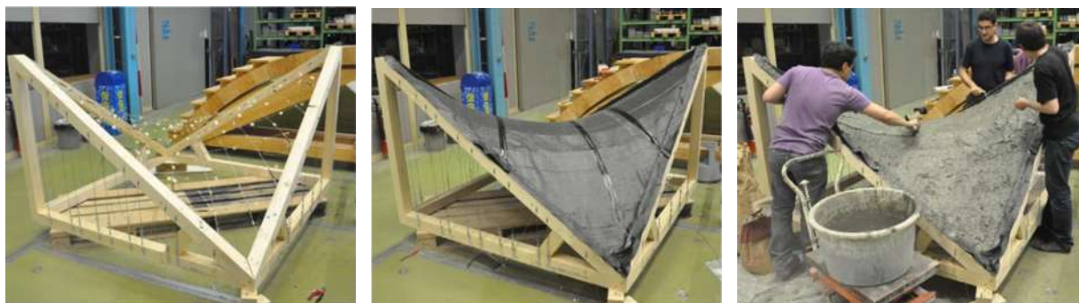
Figura 13: Proceso de colado por adición (Structures, 2014).
