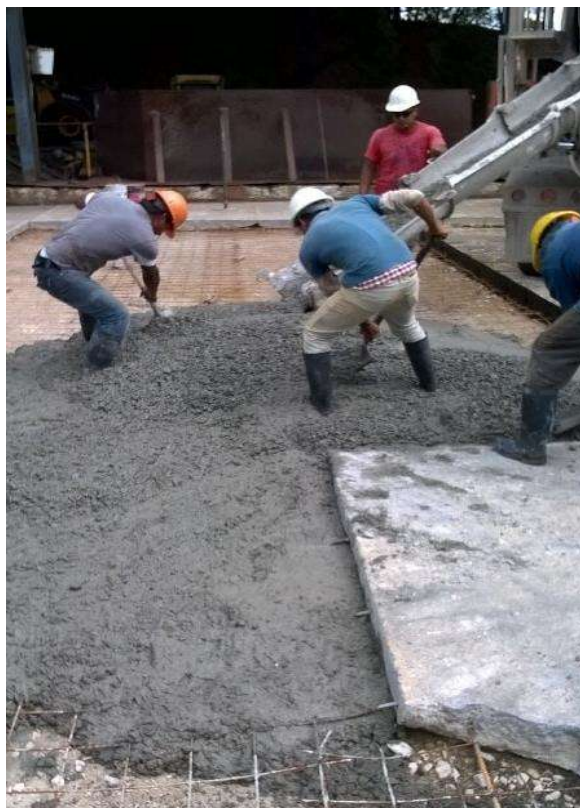
Figura 01: Colado de piso de concreto premezclado adicionado con CBC 20% respecto al peso del cemento.
