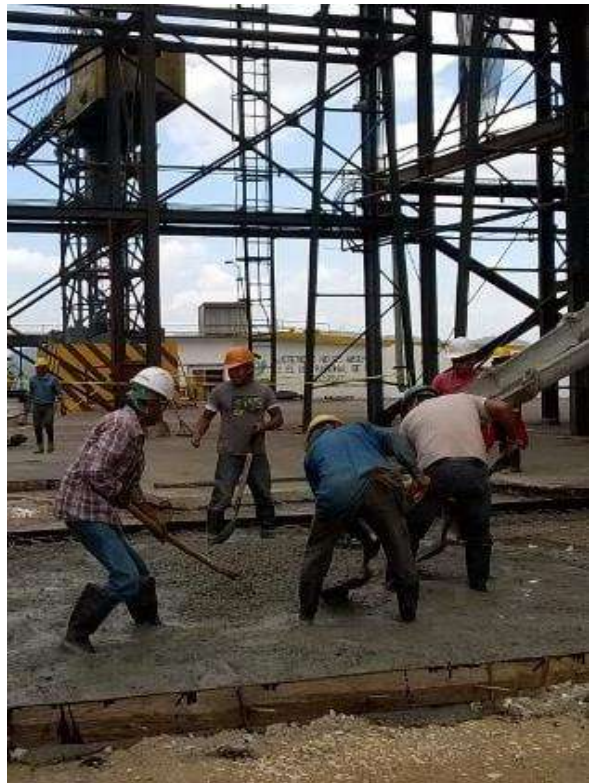
Figura 02: Reparación de patio de maniobras en alcoholera de Zapopan.
