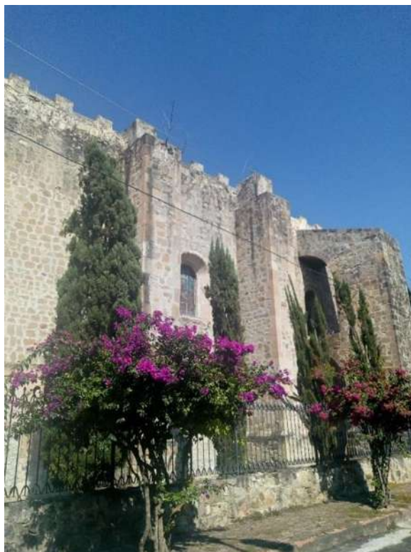
Figura 15. Contrafuertes y arbotante, convento de Capula, Michoacán.
