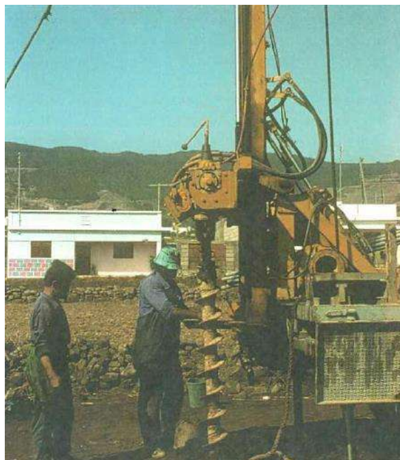
Figura 2.20. Sondeo helicoidal (González Vallejo et al., 2002).
