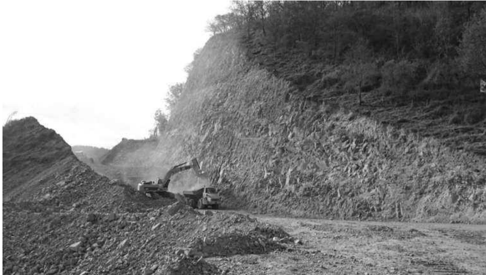
Figura 3.10. Estado actual del corte.
