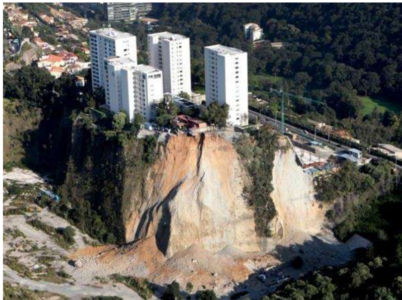
Figura 2.22. Sobrecarga estática sobre talud (Rosas, 2015)
