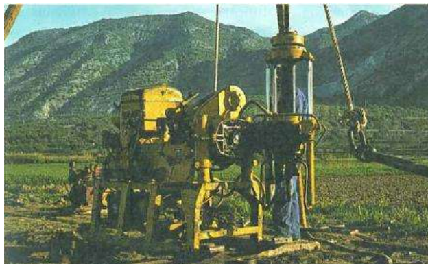
Figura 2.19. Sondeo a rotación (González de Vallejo et al., 2002).
