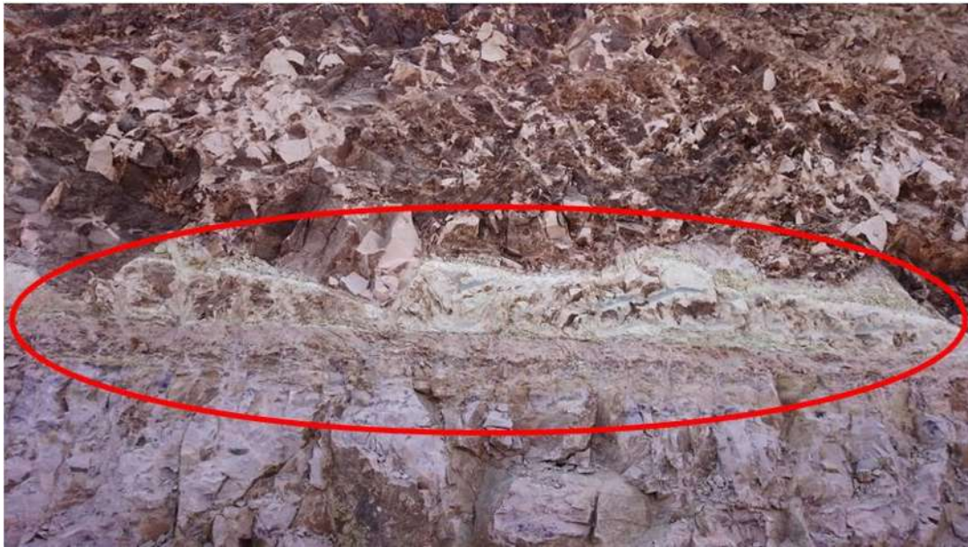
Figura 3.11. Estrato de Arcilla en talud de corte.
