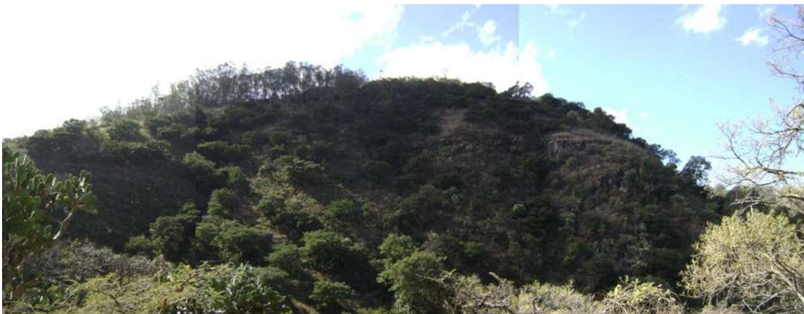
Figura 3.4. Talud de estudio.
