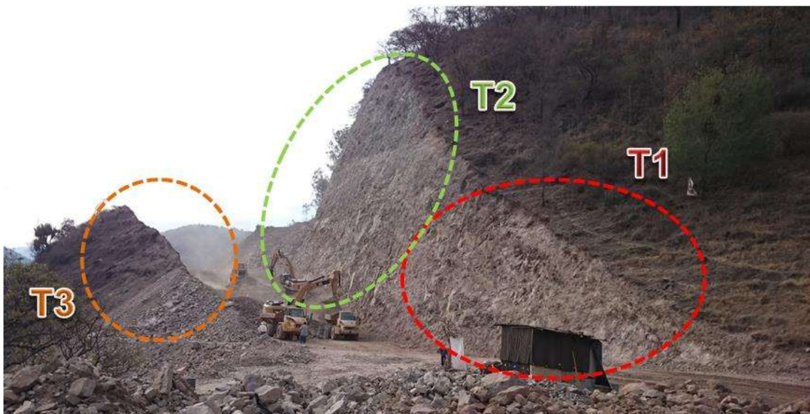
Figura 3.12. Ubicación de los diferentes taludes dentro del corte.
