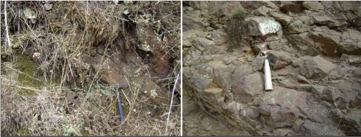
Figura 3.6. Afloramientos de Macizos rocosos en el talud.
