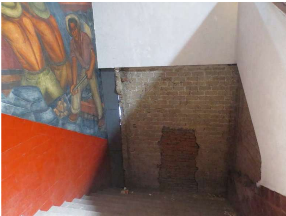
Imagen 34: Muro de concreto. Tomada por la autora.
