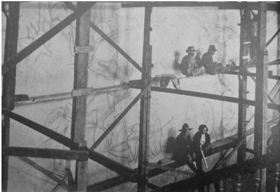
Imagen 6: Ione Robinson y Diego Rivera sentados en el andamio en Palacio Nacional. Tomada de Ione Robinson, A wall to paint on by Ione Robinson.
