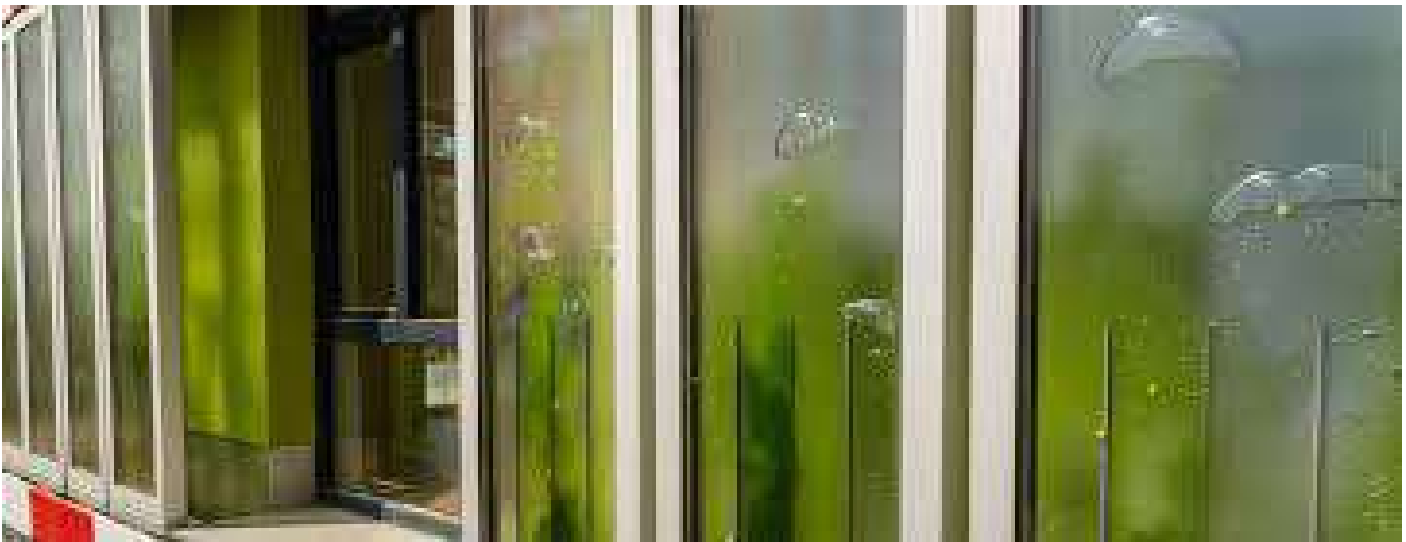
Detalle fachada edificio “Bio Intelligent Quotient”. Fuente: Slitter-Werk y ARUP
