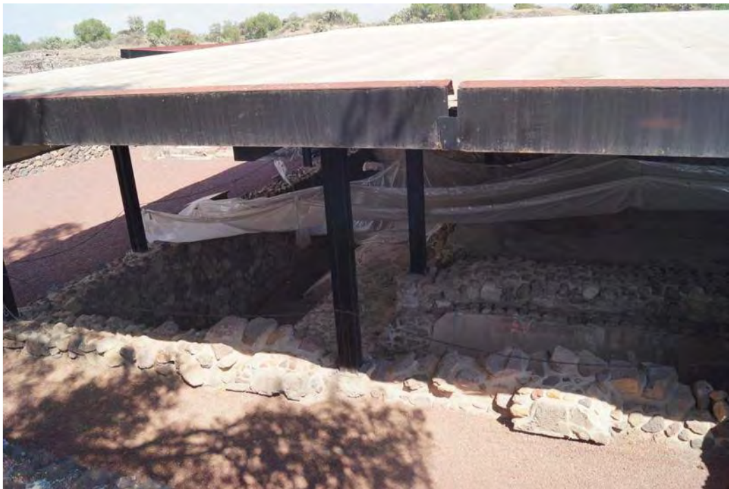
Imagen 127.- Restauración protegida en la zona de Edificios Enterrados, importante espacio poco explotado en la visita.
