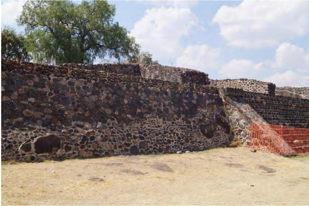
Imagen 126.- Formato general de la restauración en Teotihuacán, etapas señaladas con la mezcla, rajueleado y algunos elementos que sostienen un gran volumen de reposición (¿falso histórico?), señalando el aspecto cancelado de la circulación vertical en la derecha.
