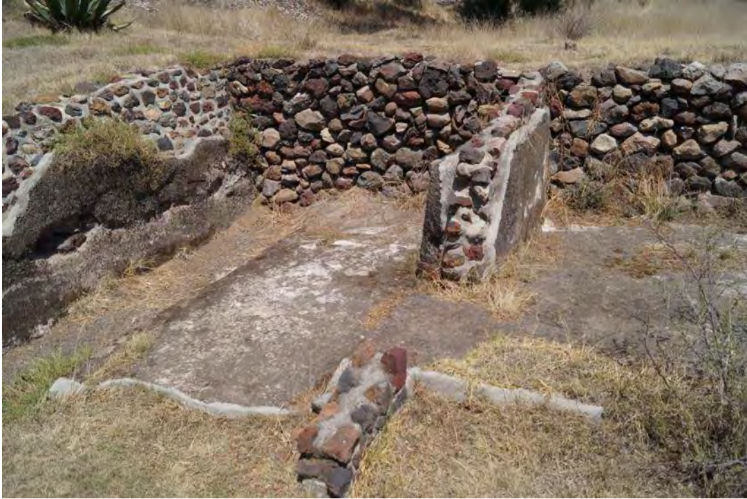
Imagen 118.- Vestigios de muros y aplanados conservados sin ninguna señalética y protección secundaria, en camino al museo.
