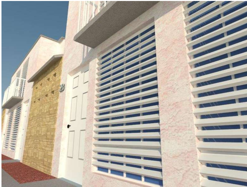
Figura V.5 Uso de dispositivos de regulación solar en ventanas ( Louvers )
