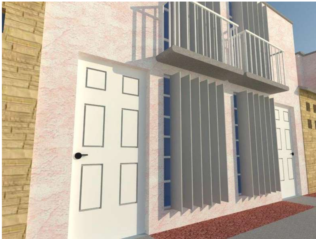
Figura V.7 Uso de dispositivos de regulación solar en ventanas ( Partesoles )
