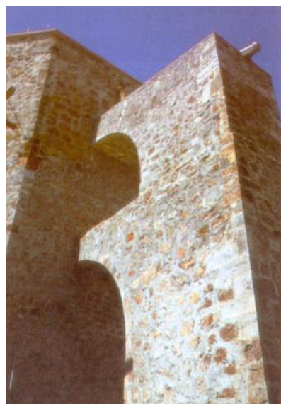
Imagen 31. Fotografía del arco botarel. Ibidem , p. 50.
