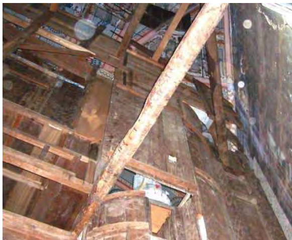
Imagen 11. Estructura de madera del retablo principal del templo de la Soledad en Tzintzuntzan, Michoacán. (vista posterior).
