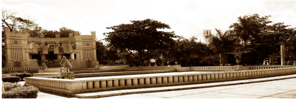
Imagen 77. El Parque de la Américas construido en el antiguo barrio de San Cosme, hoy parte de la Colonia García Ginerés de la ciudad de Mérida, fue diseñado por los arquitectos Manuel y Max Amábilis y construido entre 1942 y 1945
