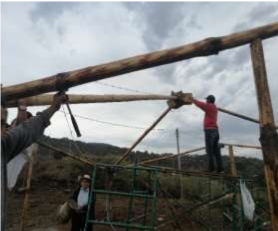
Fig. 203 Descimbrado de conectores y colocación de los otros 3 apoyos verticales
