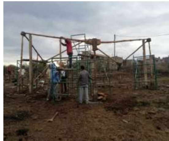
Fig. 204 Colocación de apoyos que delimitarán los accesos
