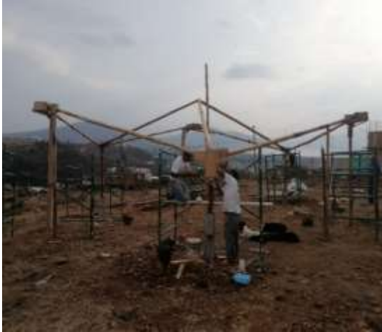
Fig. 201 Cimbrado de conectores
