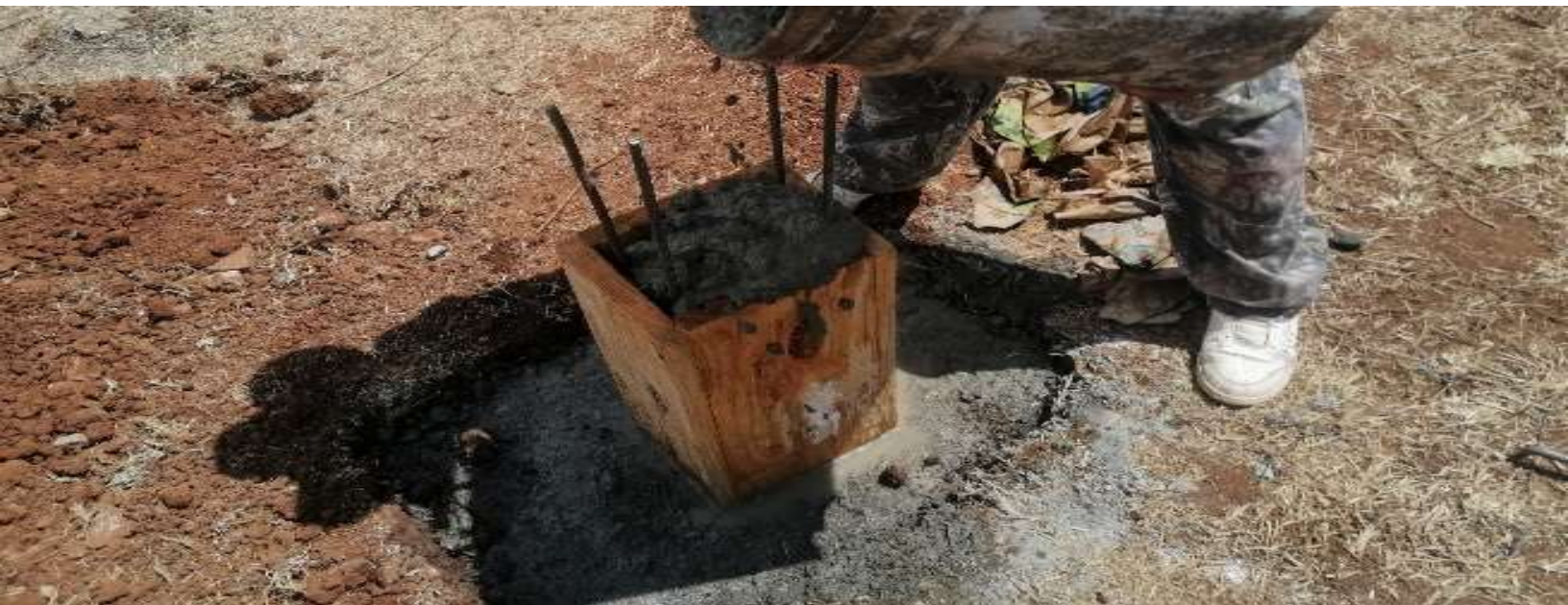
Fig. 178 Preparación de mezcla para los apoyos aislados
