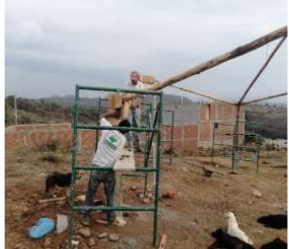
Fig. 202 Colado de conectores
