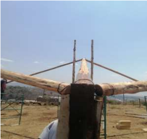
Fig. 190 Colocación de murillo en la zapata
