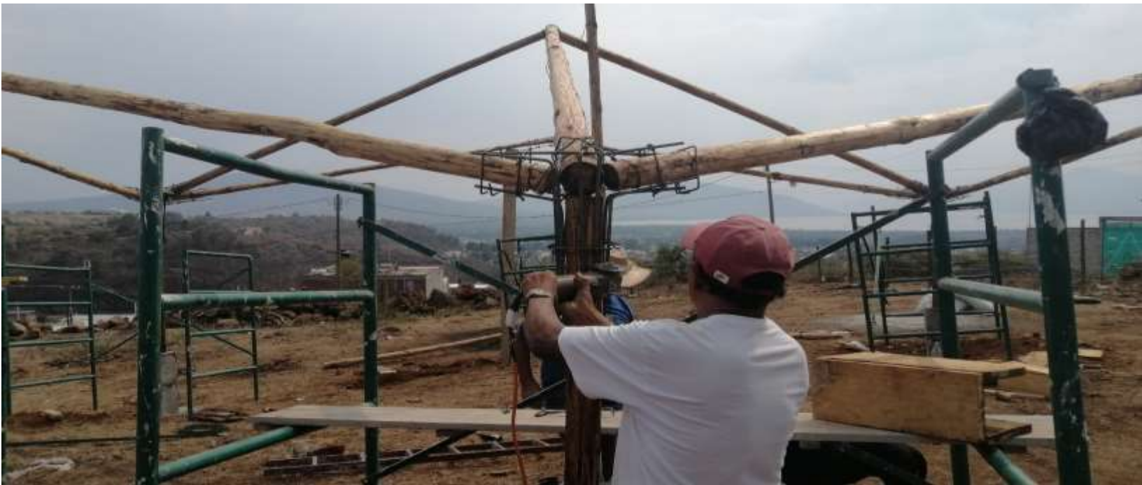
Fig. 198 Armado de nudos conectores con varilla de 3/8" para colado de concreto
