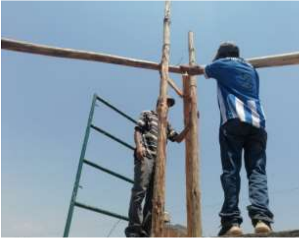
Fig. 188 Colocación en el centro de gravedad de cubierta
