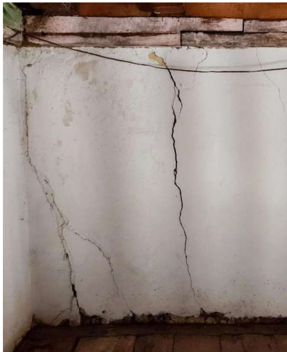
Fig. 100 Grietas en el área del coro junto a la portada. Fotografía: ASS.
