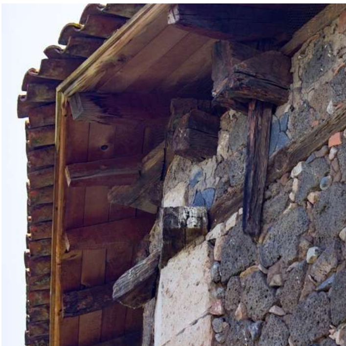
Fig. 133 Visualización del sistema de arrastres y de grapas. Autoría: Adrián Solís.
