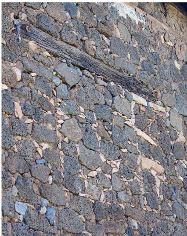
Fig. 110 Vano tapiado en muro norte. Fotografía: ASS.
