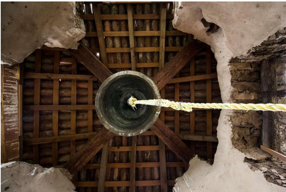
Fig. 79 cubierta de la torre campanario. Fotografía: ASS.
