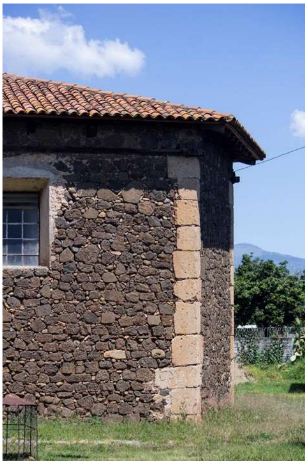
Fig. 74 Cadena de ángulo de cantería. Fotografía: ASS.
