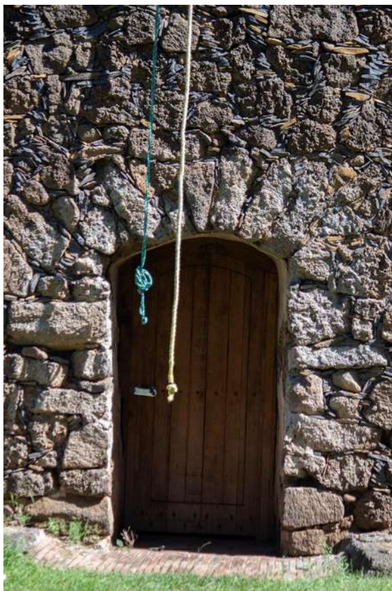
Fig. 77 Vano de acceso a la torre. Fotografía: ASS.
