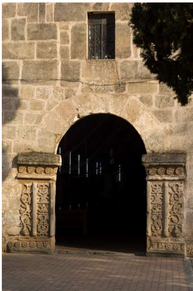
Fig. 58 Acceso a la nave. Fotografía: ASS.
