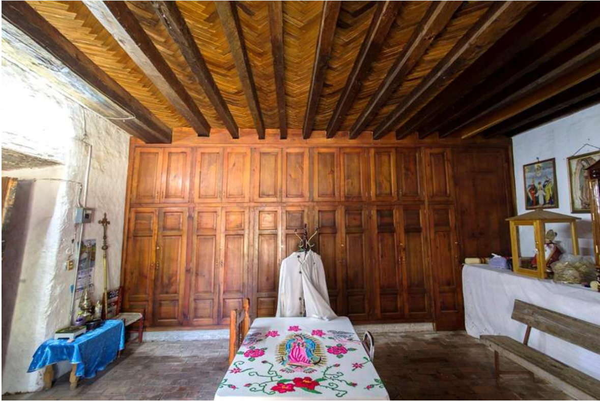
Fig. 127 Sacristía con cubierta de madera y tapa de tejamanil. Fotografía: ASS.
