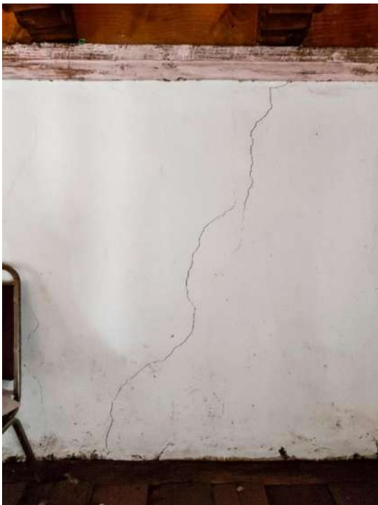
Fig. 100 Grietas en el área del coro junto a la portada. Fotografía: ASS.
