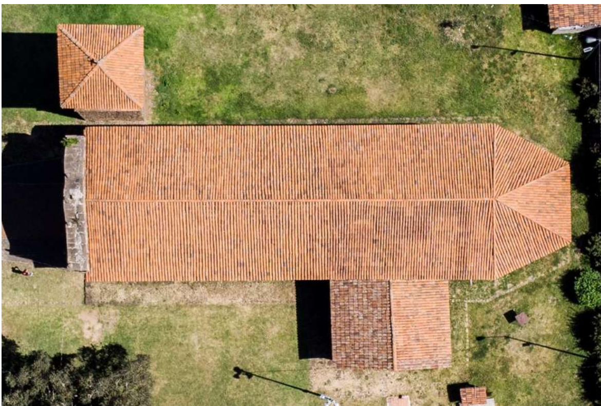
Fig. 72 Cubiertas. Fotografía: ASS.
