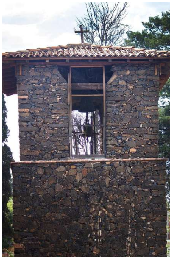
Fig. 78 Vista oriente de la torre campanario. Fotografía: ASS.
