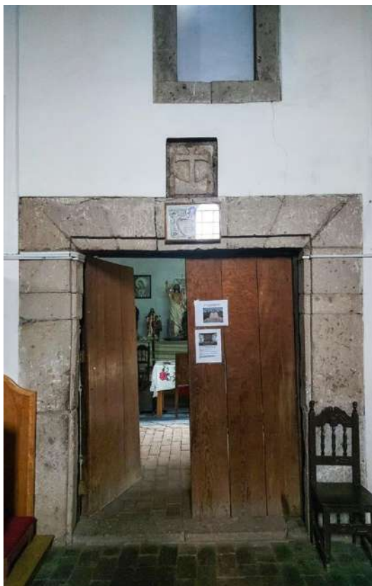
Fig. 84 Puerta entre la nave y la sacristía. Autoría: Adrián Solís.
