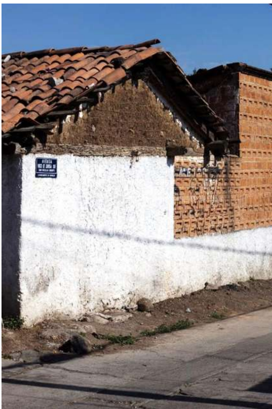
Fig. 27 Vivienda vernácula intervenida. Autoría: Adrián Solís.
