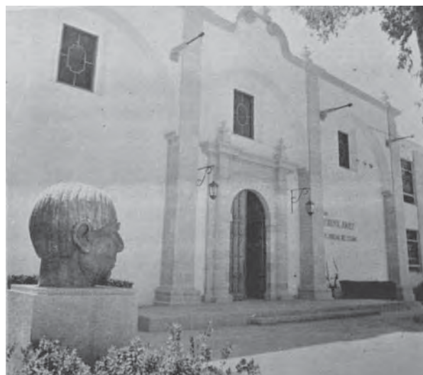
Fig. 1.26 Palacio de Justicia o Edificio Juárez. Refuncionalización del antiguo Edificio de Las Recogidas, obra realizada por la firma Cossio-Algara, entregado en 1972. Reprografía ESSL, (Sep. /1973).
