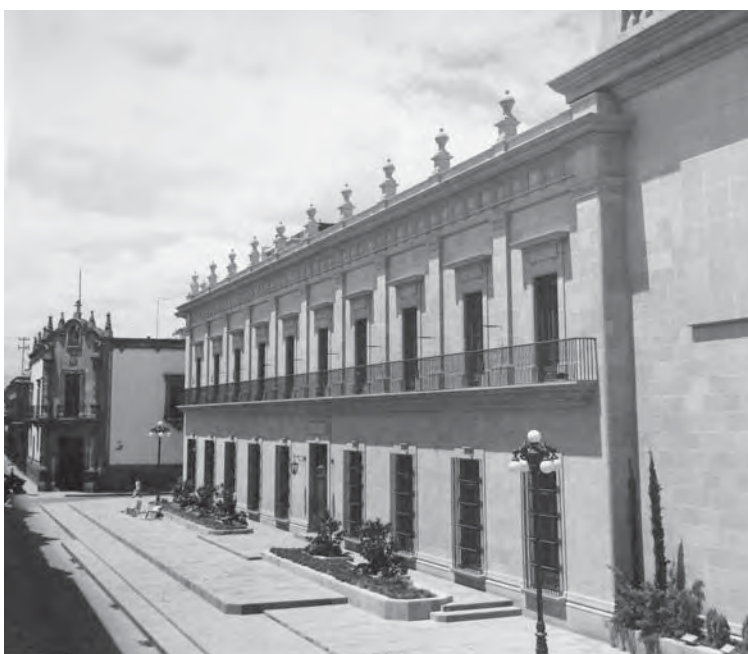
Fig. 1.45 Plazoleta y portada sur del Palacio de Gobierno una vez concluida la obra. Al fondo se aprecia el ochavo de la Caja Real. Fotografía BJGVMFC.
