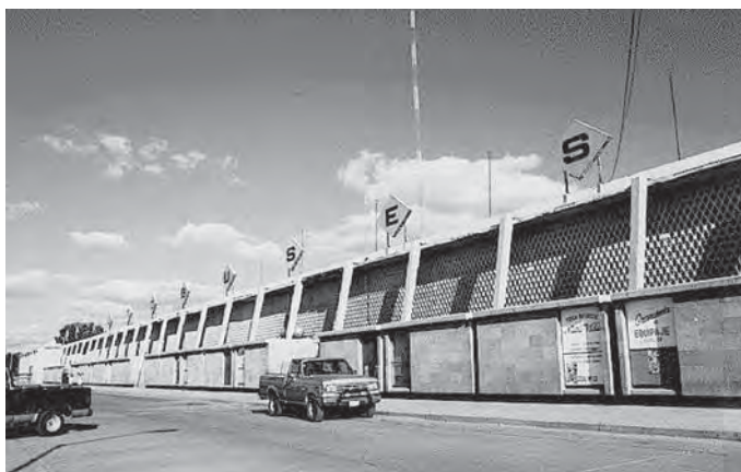
Fig. 3.1 Antigua Central de Autobuses, erigida bajo el ayuntamiento de Fonseca Álvarez (1967-1970). Imagen INEGICC.
