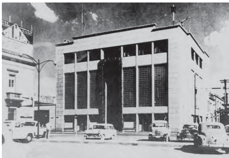
Fig. 1.8 Banco del Centro (1954), edificado en el costado sur de la Plaza de los Fundadores. Proyecto y obra Ing. Flavio Madrigal. Imagen de la época BRAMFC.
