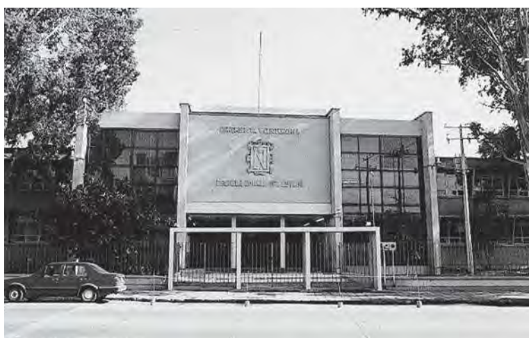
Fig. 1.3 Escuela Normal del Estado de San Luis Potosí (1945). Coautor Arq. Alonso Mariscal, contratistas: Ing. Luis Artega y Roberto E. Valle, supervisión: Arq. Francisco Cossío. Imagen INEGICC.
