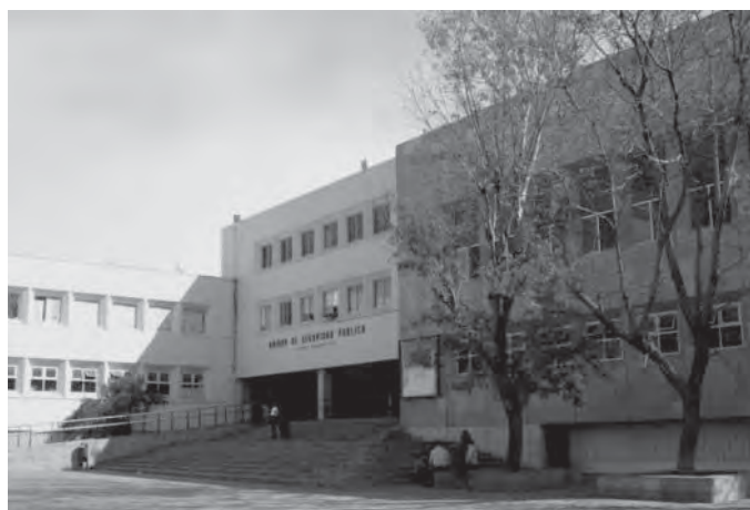
Fig. 3.6 Aspecto actual de la Unidad de Seguridad, complemento de la Unidad Administrativa. ACP.
