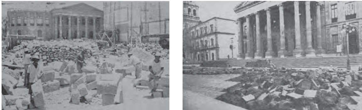
Fig. 2.26 Dos imágenes de la Plaza del Carmen en proceso de construcción. A la izquierda canteros preparados para tallar la piedra del Palacio Federal, a la derecha reparación de la calle Villerías. Reprografía ESSLP (Ago. /1972) y ESSLP (Feb. /1973)
