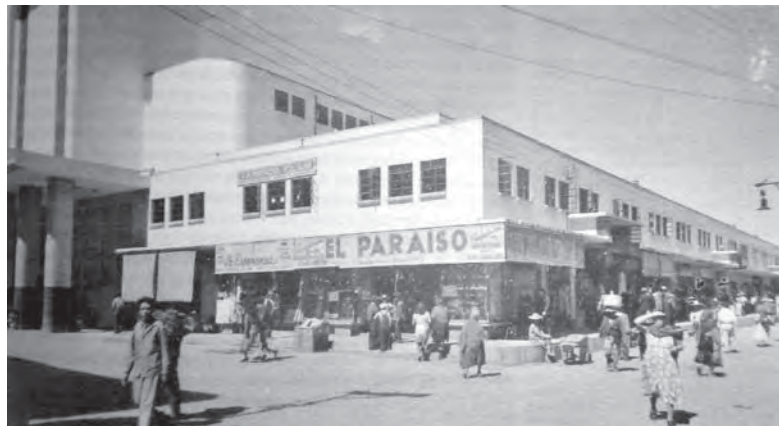
Fig. 3.22 Imagen de la fachada principal del Mercado Hidalgo a mediados del siglo pasado. Reprografía JVAUSLP.
