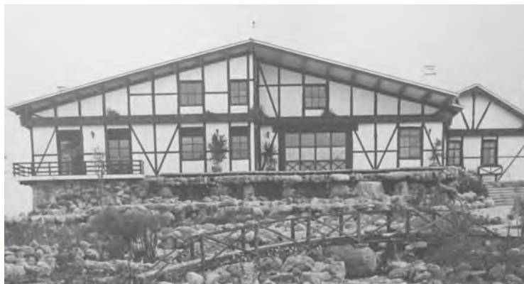
Fig. 1.19 Jardín de Niños La Venadita. Localizado al norte de la ciudad en la Colonia Industrial Aviación. Edificado por el Ing. Francisco de la Rosa y los Arq. Carlos del Valle y Gerardo Rosillo. Inaugurado en Septiembre de 1973. Fotografía SARCMFC.
