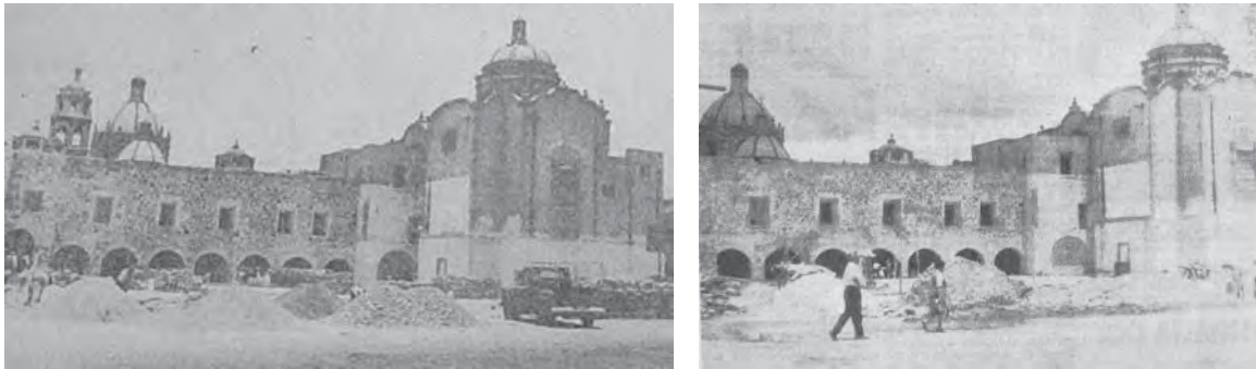
Fig. 2.14 Plaza de Aránzazu en obra. Los constructores se acercaron al INAH para realizar la intervención de este espacio de carácter histórico. Reprografía EH (Jul. /1970) y ESSL (Ago. /1970).
