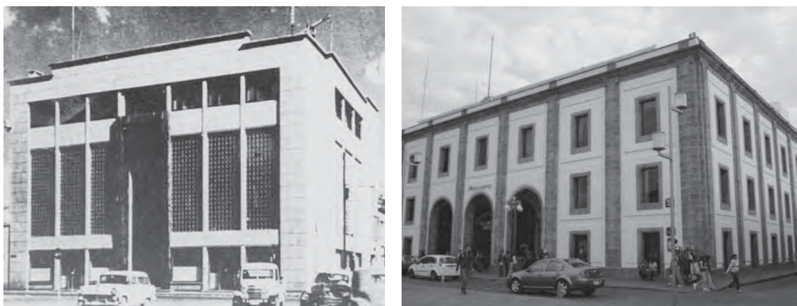
Fig. 1.33 Banco del Centro antes y después de la intervención del Arq. Marco Antonio Garfías, realizada en la década de los ochenta del siglo pasado. Ubicado en el flanco sur de la Plaza de los Fundadores. A la izquierda detalle de imagen de los años sesenta BRAMFC, a la derecha imagen reciente ACP.
