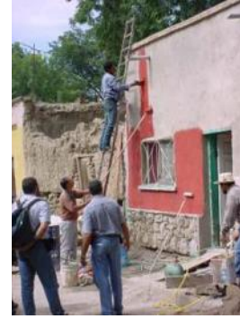
Figura 40. Aplicación de la pintura de cal. En Manual de Conservación de Edificios Históricos
