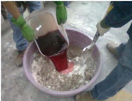
Figura 13. Adición de sangre al mortero
