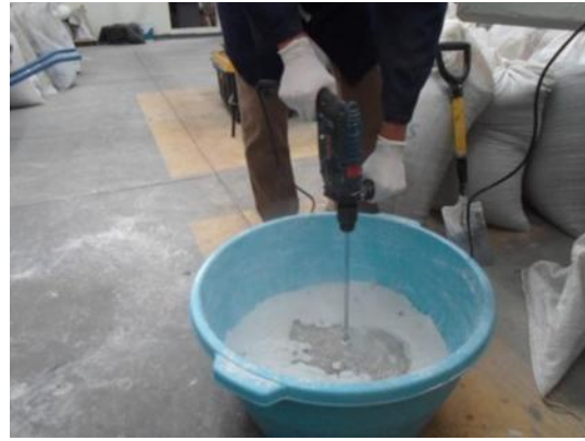
Figura 12. Amasado con ayuda de taladro mecánico. Foto: AJVP
