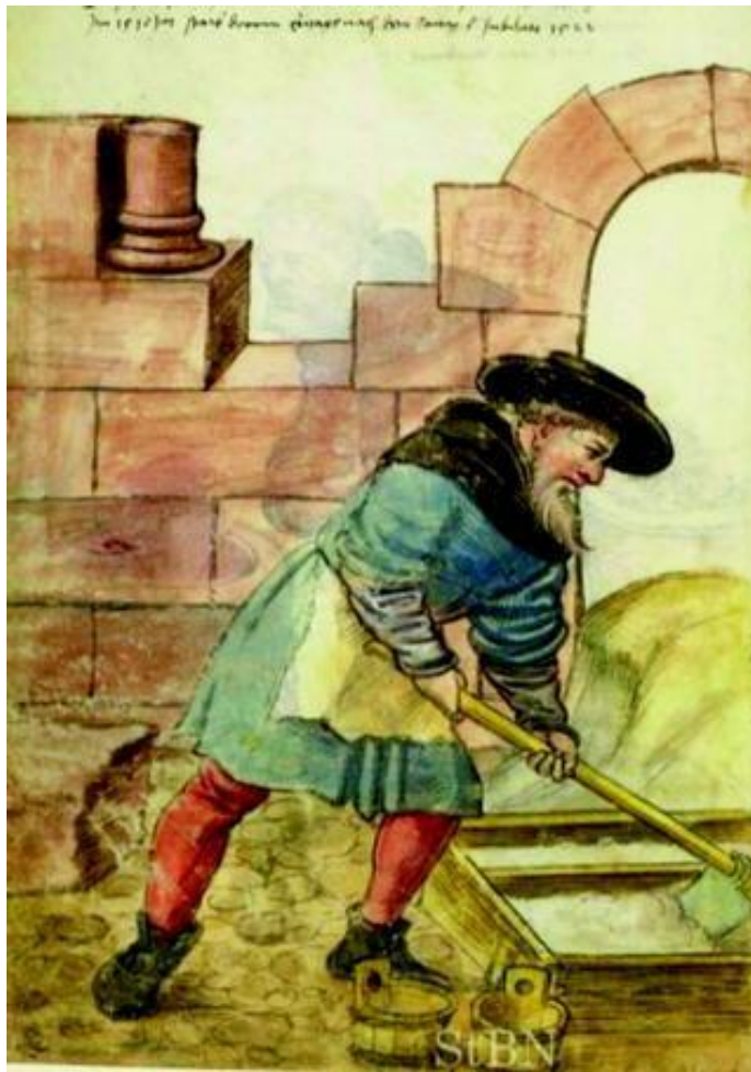
Figura 5. Preparación del mortero de cal en el siglo XVI. Fuente: Cornelia Marinowitz, Claudia Neuwald-Burg, y Matthias Pfeifer, Historic Documents in Understanding and Evaluation of Historic Lime Mortars , Vol. 7, Springer Netherlands, 2012, pp. 15-24.
