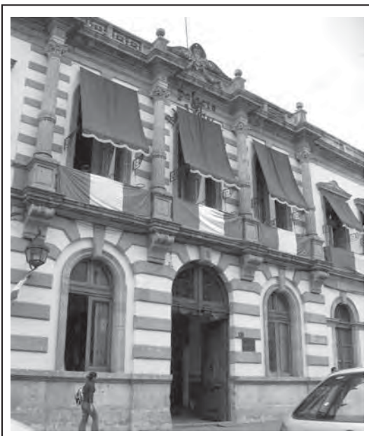
Fig. 93 Arquitectura del centro de Morelia. Fotografía de la autora
