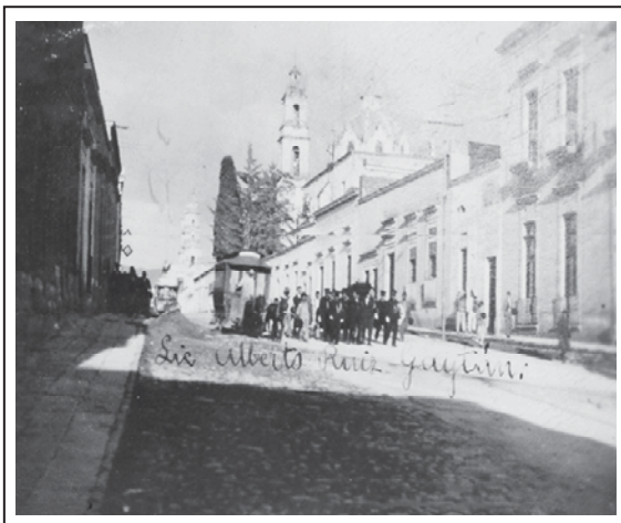
Fig. 68 Vista de la calle Nacional de Morelia (actualmente Av. Madero poniente). Tomada de Archivo fotográfico, Fondo Gerardo Sánchez Díaz, Instituto de Investigaciones Históricas, UMSNH.
