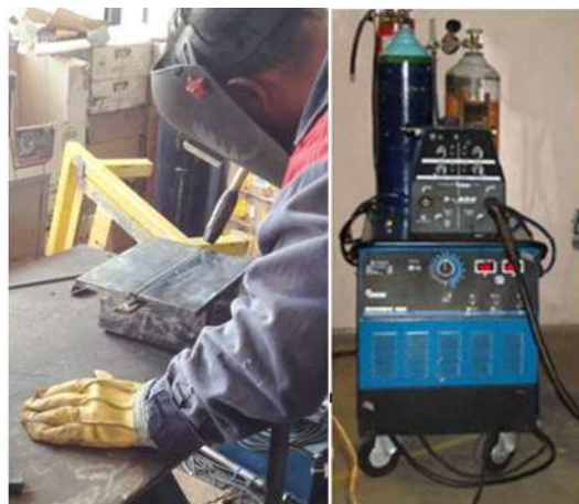
Figura 2. 5.- Aplicación del proceso de soldadura.
