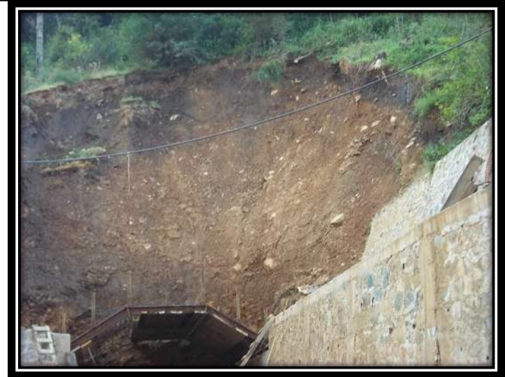
Deslizamiento producido por la mina, pero este deslizamiento está afectando un camino.
