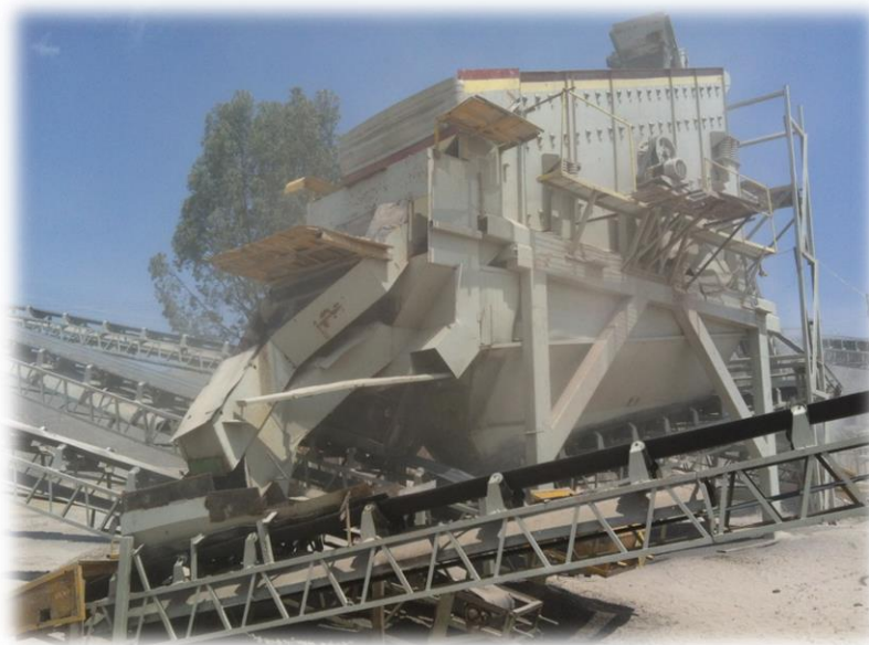
Figura 3.5. Proceso de trituración en el banco de materiales de “Asfaltos Guadalajara”
