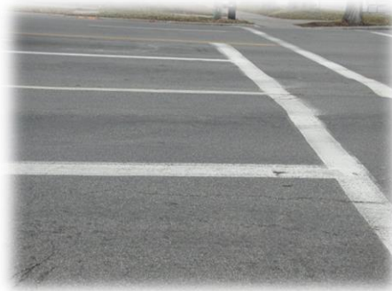
Figura 1.10. Ahuellamiento
